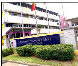
Kampus Jalan Othman
