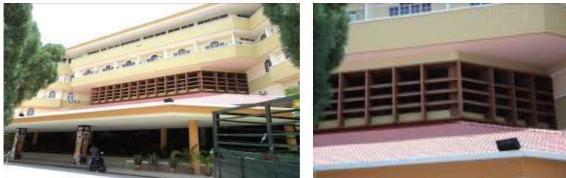
Gambar 2: Contoh Alat Peneduhan “Hung Louvers” Yang Digunakan Pada Arah Barat Bangunan Canselori USM
