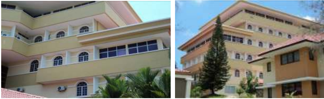
Gambar 1: Tidak Terdapat Sebarang Alat Peneduhan Pada Tingkap Bangunan Canselori USM
