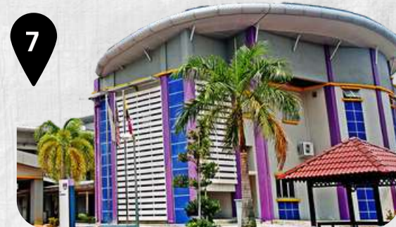
PTAR Kampus Teluk Intan
