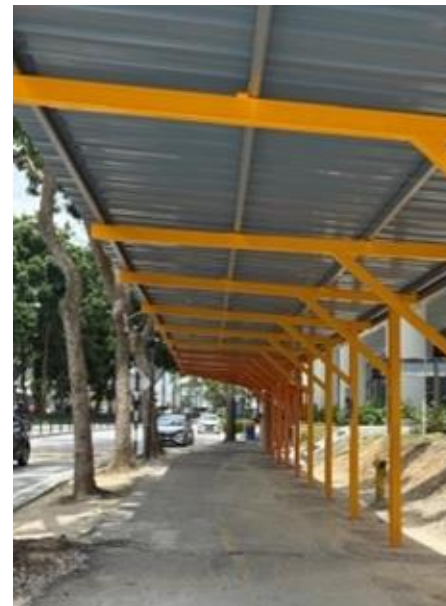
KERJA-KERJA MEMBINA LALUAN PEJALAN KAKI BERBUMBUNG
