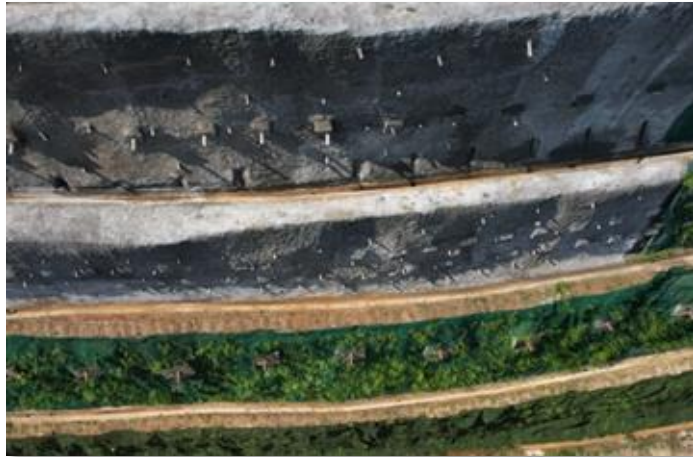
KERJA-KERJA PEMBAIKAN CERUN RUNTUH (CERUN 2)
