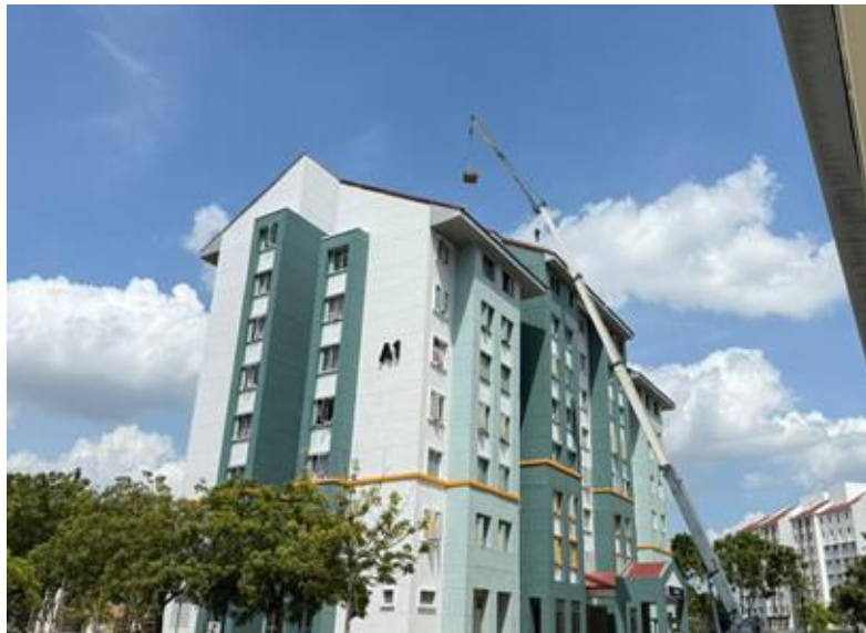
KERJA-KERJA PENGANTIAN GENTING BUMBUNG KONKRIT DI KOLEJ-KOLEJ RAFFLESIA DAN ANGSANA
