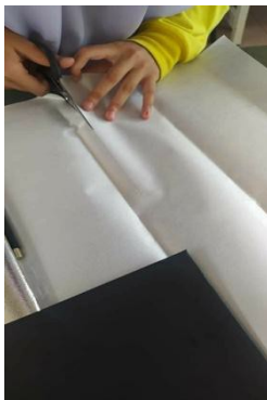
LANGKAH 4 PEMASANGAN WALLPAPER DALAM
