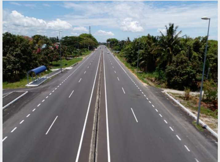
Gambar 1: Jalan baru yang menghubungkan Teluk Intan dan Klang
