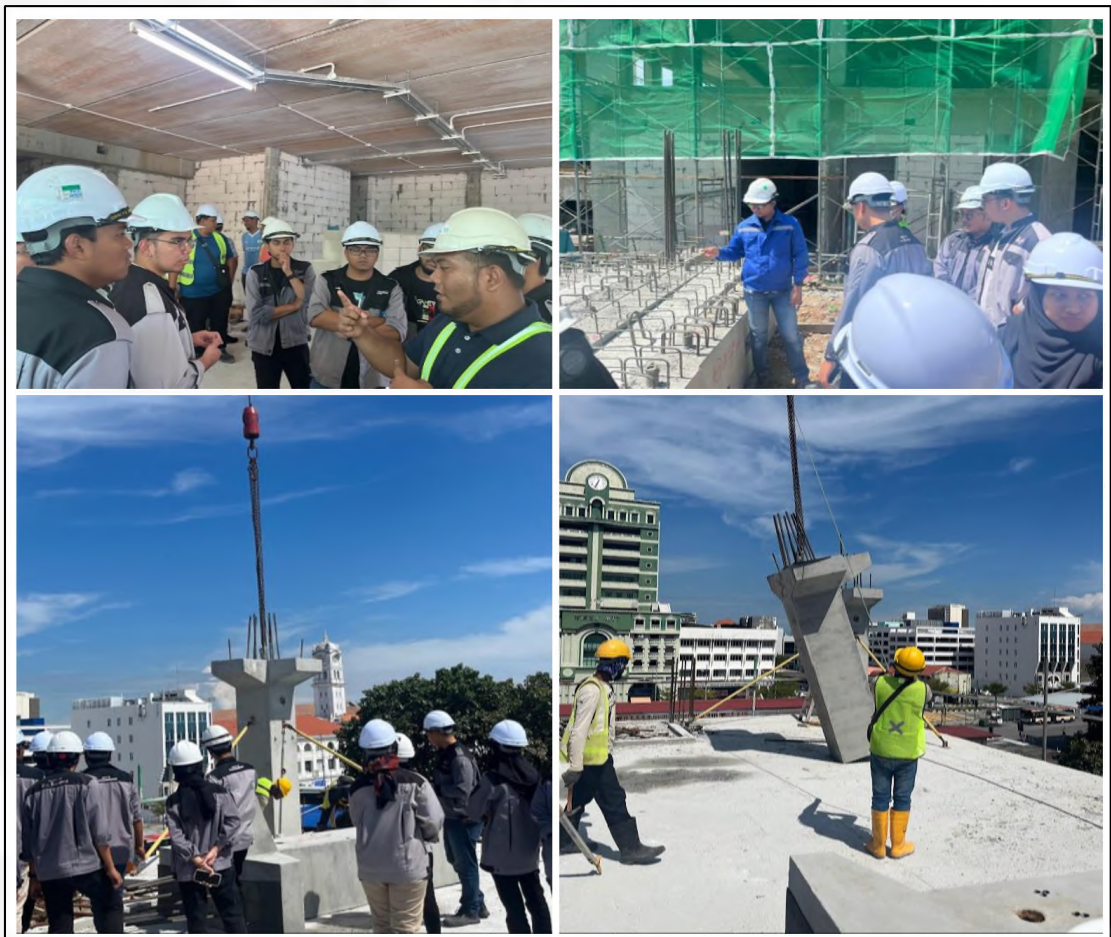
Gambar 3: Aktiviti pemasangan tiang IBS di tapak bina
