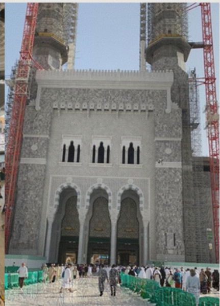
Yom merakam foto pintu Masjidil Haram yang dikenali sebagai Pagar atau Pintu Raja Abdul Aziz, di mana Kaabah boleh dilihat terus dari pintu masuk utama ini.
