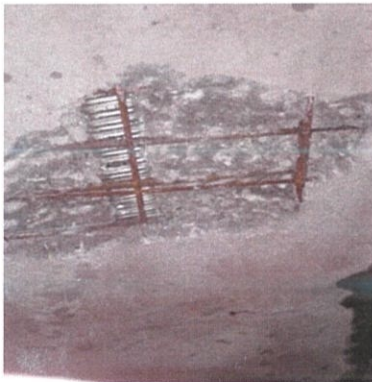
Figure 3.4.1 a): hacking remove loose material
