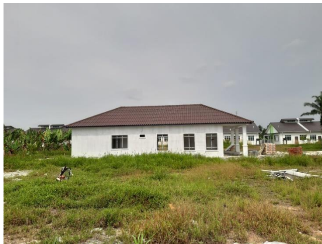
Figure 16: En. Anuar empty land
