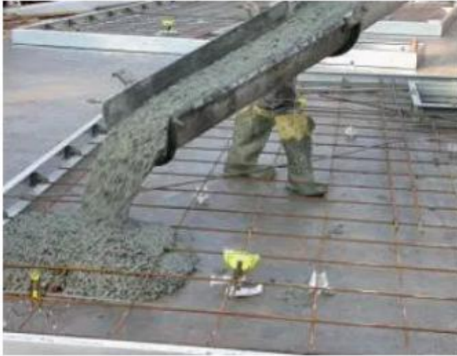
Image 2.2: Pour of Concrete
