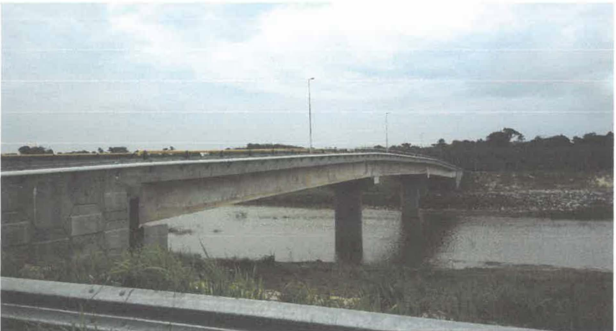
Gambar 13: Kemudahan jembatan di Lubok Selumar
