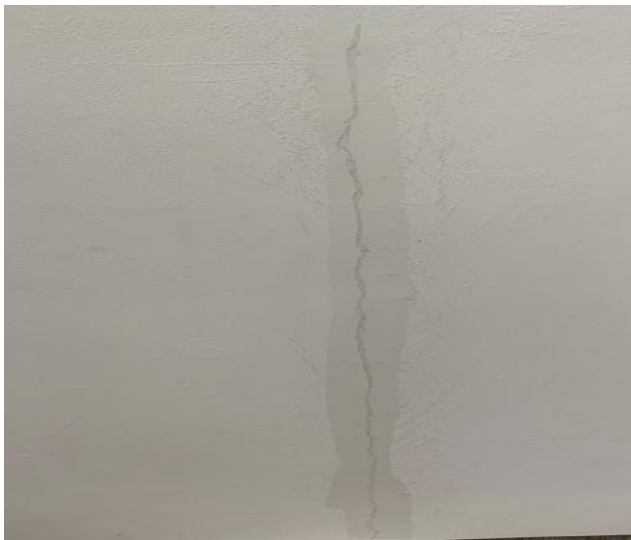
Figure 7: pour silicon
