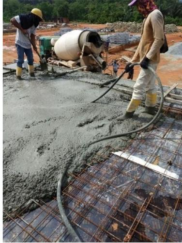
*Figure 16 Concrete pouring*
