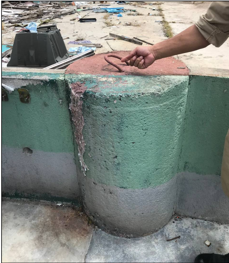
“Anti-tank blocker” yang masih berada di kawasan Buloh Kasap, Segamat, Johor
