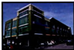
PTAR Mukah Campus
