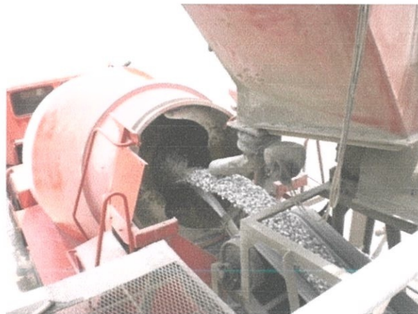
Gambar foto 4.0: bahan-bahan dimasukkan kedalam lori
