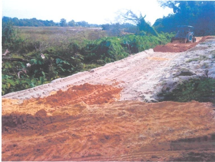
Gambar foto 4.11:Penambakan tanah (1 kaki) dan pasir
