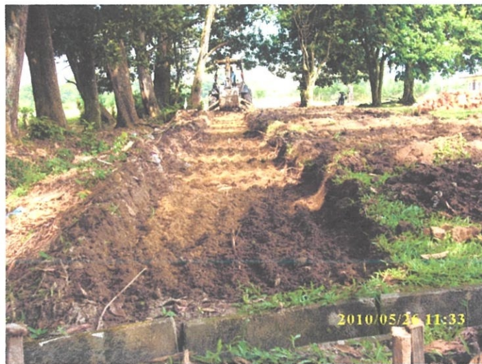
Gambar foto 4.10: Kerja pengorekan tanah atas (tapak cadangan B)
