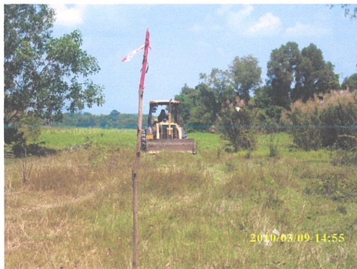
Gambar foto 4.9: Pembersihan tapak di kawasan paya (tapak cadangan C)
