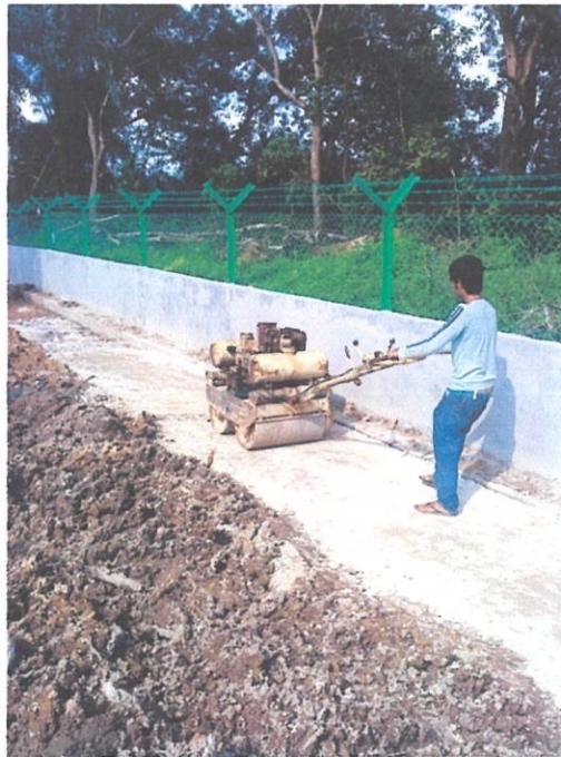
Gambar foto 4.14: Kerja-kerja pemadatan
