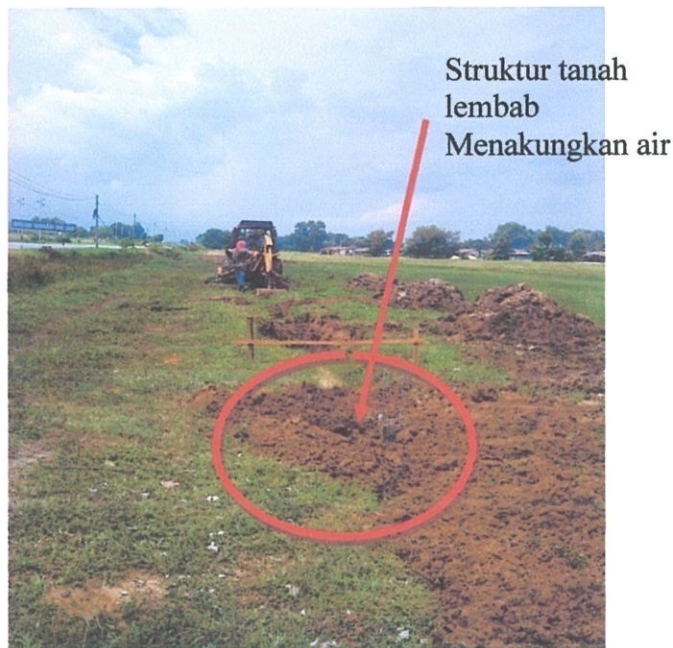
Gambar foto 5.2: Keadaan tanah yang mengandung peratus air yang lebih
