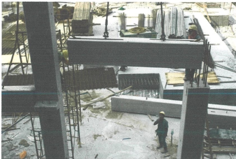
Foto 4.12: Pekerja sedang memasang rasuk
