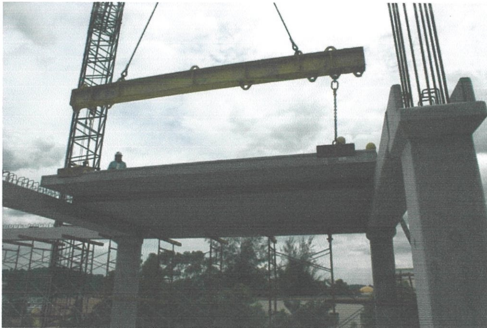
Foto 4.13: Pemasangan Papak Berongga Pra-tuang
