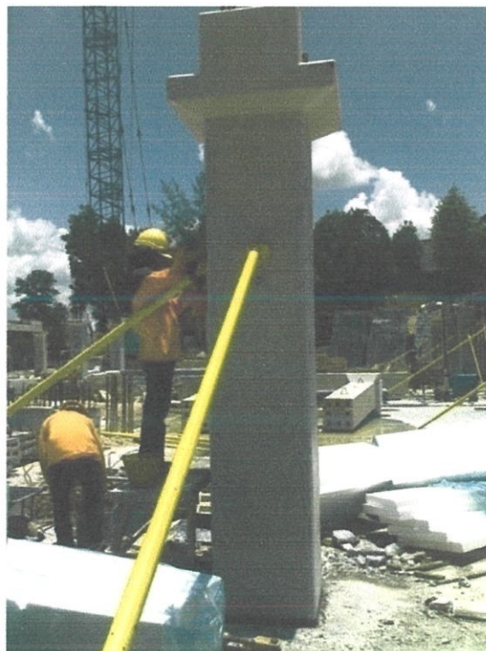
Foto 4.9: Memasang tupang pada tiang
