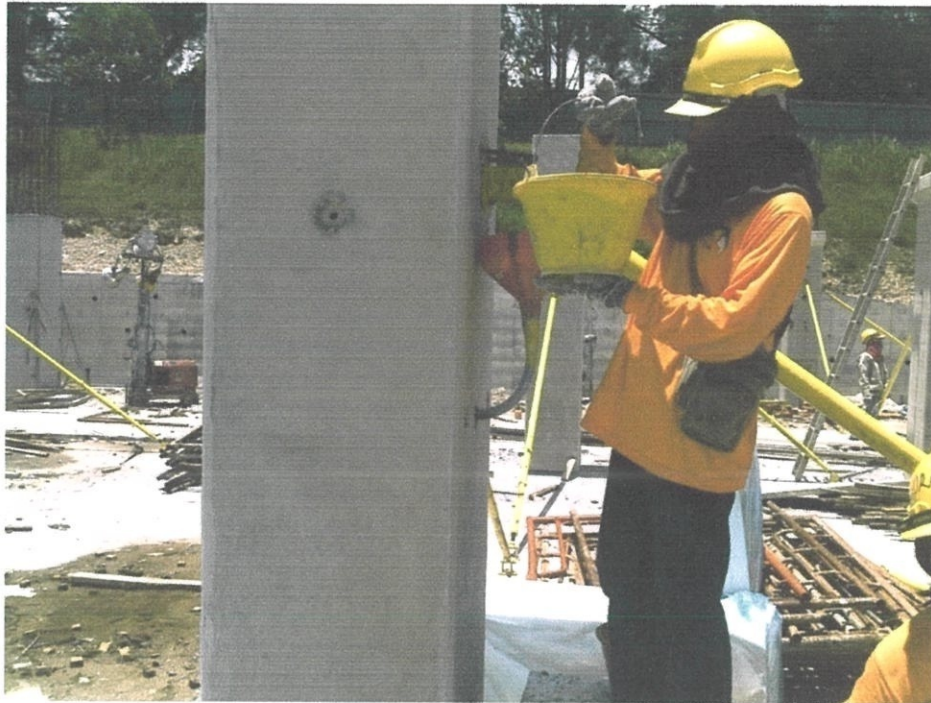
Foto 4.10: Penuangan simen mortar kedalam rongga tiang
