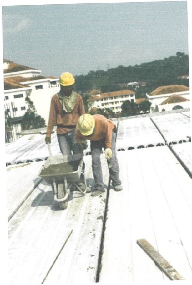
Foto 4.16 Bancuhan E-mix dituang di antara sambungan papak
