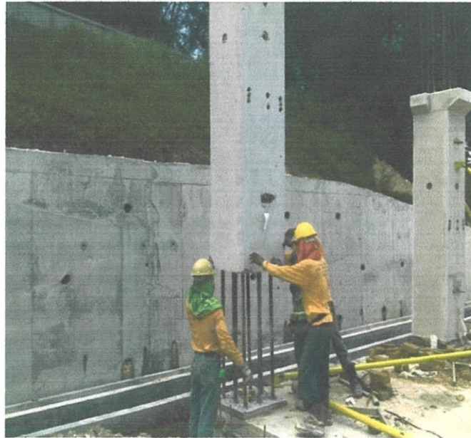
Foto 4.8: Pemasangan tiang konkrit pra-tuang oleh pekerja
