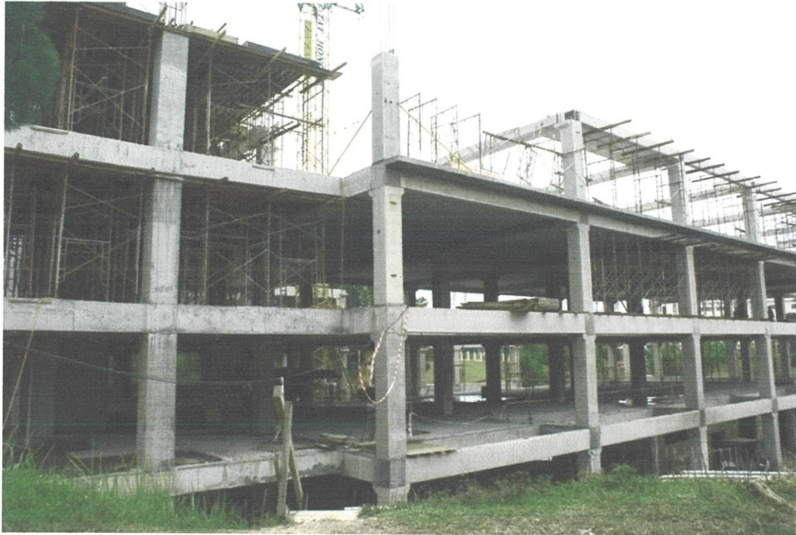
Foto 4.0: Pembinaan bangunan tambahan pusat pameran dan multimedia OSH di ibu pejabat NIOSH, Bandar Baru Bangi, Selangor
