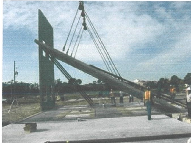
Foto 3.6: pemasangan secara tilt up
