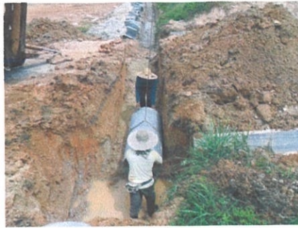
Gambar 3.15 & 3.16 Kerja-kerja meletakkan dan menyambung longkang.
