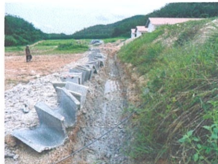
Gambar 3.13 & 3.14 Kerja menyusun longkang di tapak bina sebelum disambung.
