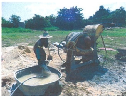
Gambar 3.22 Mesin pembancuh simen dikendalikan oleh seorang operator
