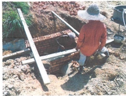
Gambar 3.17 & 3.18 Kerja mengikat bata pada 'Sum' oleh pekerja mahir.
