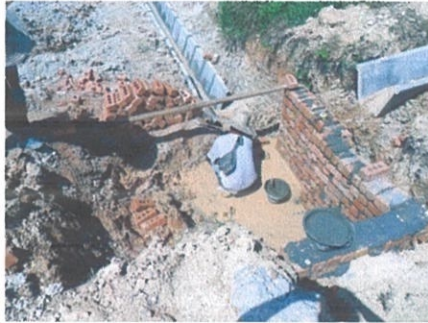
Gambar 3.23 Pekerja sedang mengikat bata pada Sum
