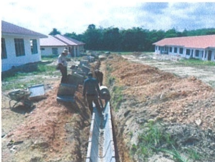
Gambar 3.13 & 3.14 Kerja menyusun longkang di tapak bina sebelum disambung.
