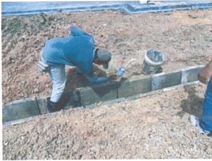
Gambar 3.15 & 3.16 Kerja-kerja meletakkan dan menyambung longkang.
