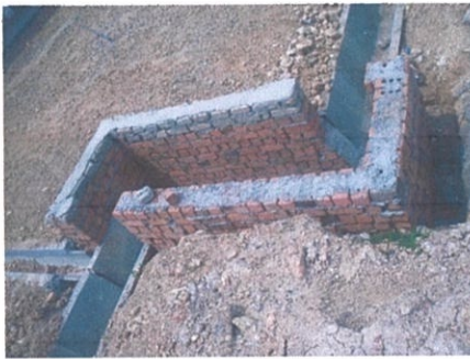
Gambar 3.17 & 3.18 Kerja mengikat bata pada 'Sum' oleh pekerja mahir.
