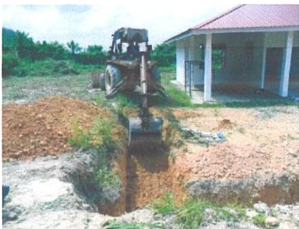
Gambar 3.10 Kerja mengorek tanah yang sedang dilakukan.
