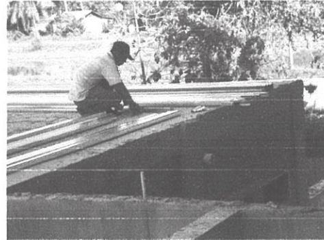
Gambarfoto 4.6c&d: Pemasangan plat dinding
