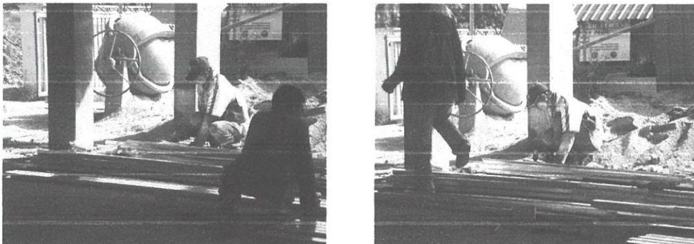
Gambarfoto 4.5a&b: Kerja-Kerja pemotongan keluli besi
