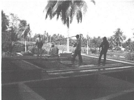
Gambarfoto 4.6c&d: Pemasangan plat dinding
