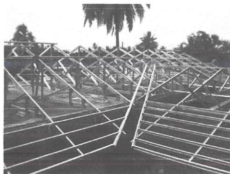
Gambarfoto 4.6i&j: Susunan kekuda bumbung
