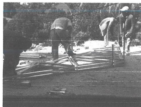
Gambarfoto 4.6a&b: Kerja-kerja setting out (membentuk kekuda)
