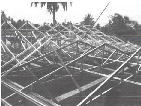
Gambarfoto 4.6i&j: Susunan kekuda bumbung
