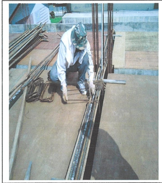
Gambarfoto 4.5 : Menunjukkan kerja-kerja membengkokkan besi
