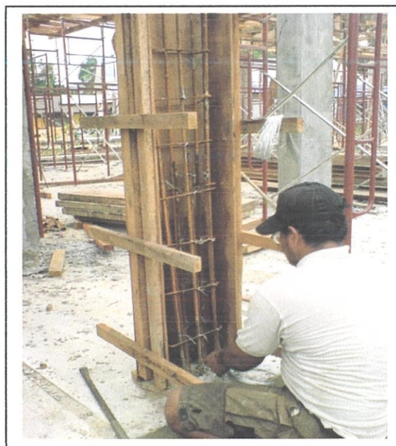
Gambarfoto 4.6 : Menunjukkan kerja-kerja mengikat besi pada tiang ( column )
