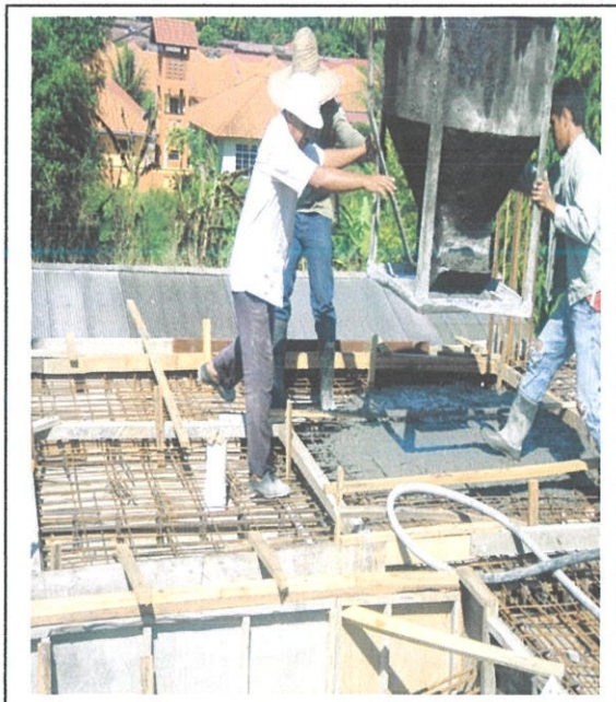
Gambarfoto 4.3 : Menunjukkan kerja-kerja konkrit pada slab dan beam
