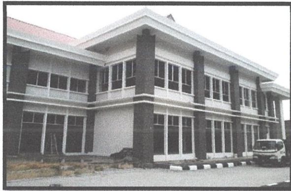
Photo 2.7 Bangunan Pejabat Tanah Langkawi
