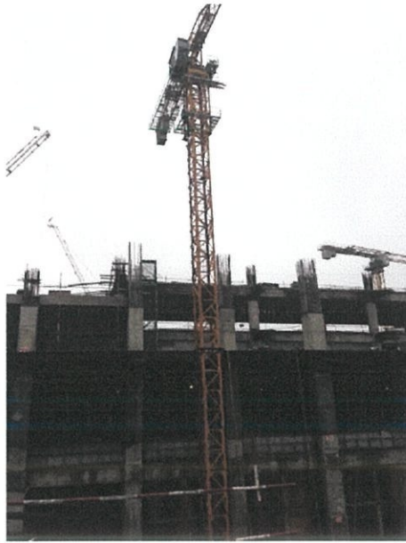
Picture : 3.16 : Tower crane
