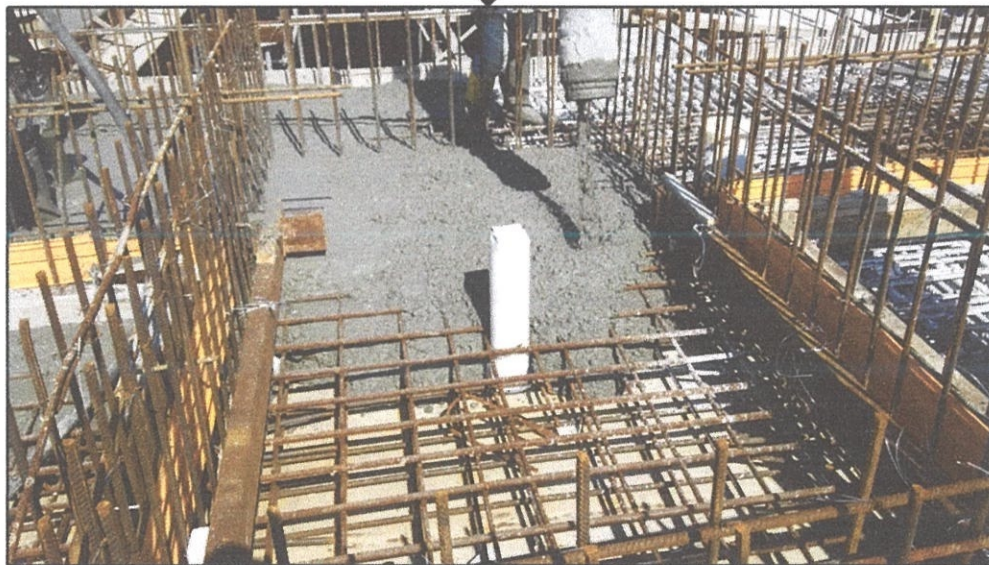
Photo 3.11 : concrete pouring.
