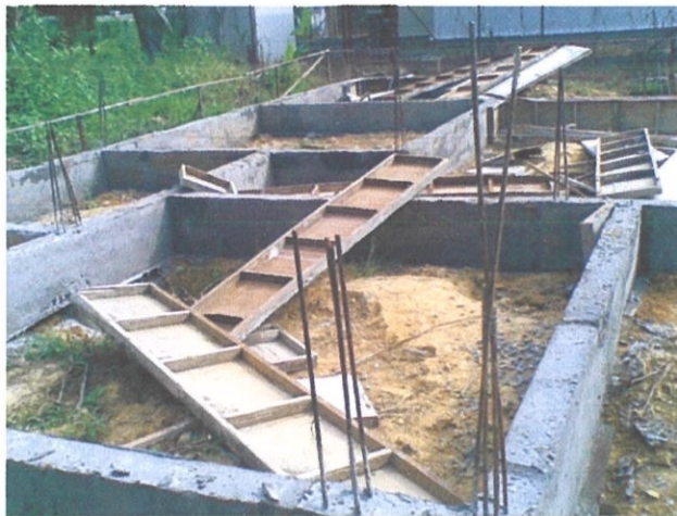
Gambarfoto 4.1 Kotak acuan yang dibiarkan bertaburan
