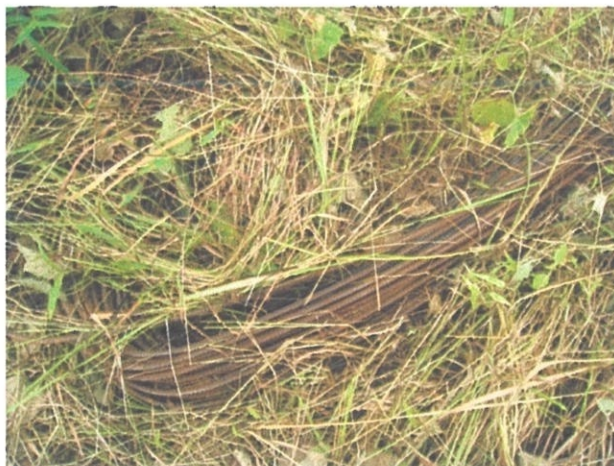
Gambarfoto 4.2 Besi tetulang yang ditinggalkan di atas tanah
