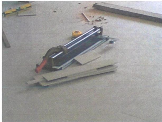
Gambarfoto 4.6 Lebihan tile semasa pemotongan
