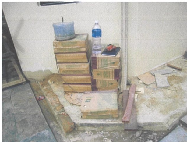
Gambarfoto 4.10 Bahan binaan yang tidak disimpan di dalam stor
