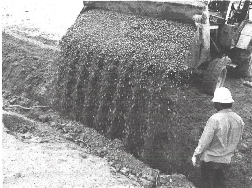
Gambarfoto 4.11: Penyelia tapak meneliti lapisan batu baur yang di isi.
