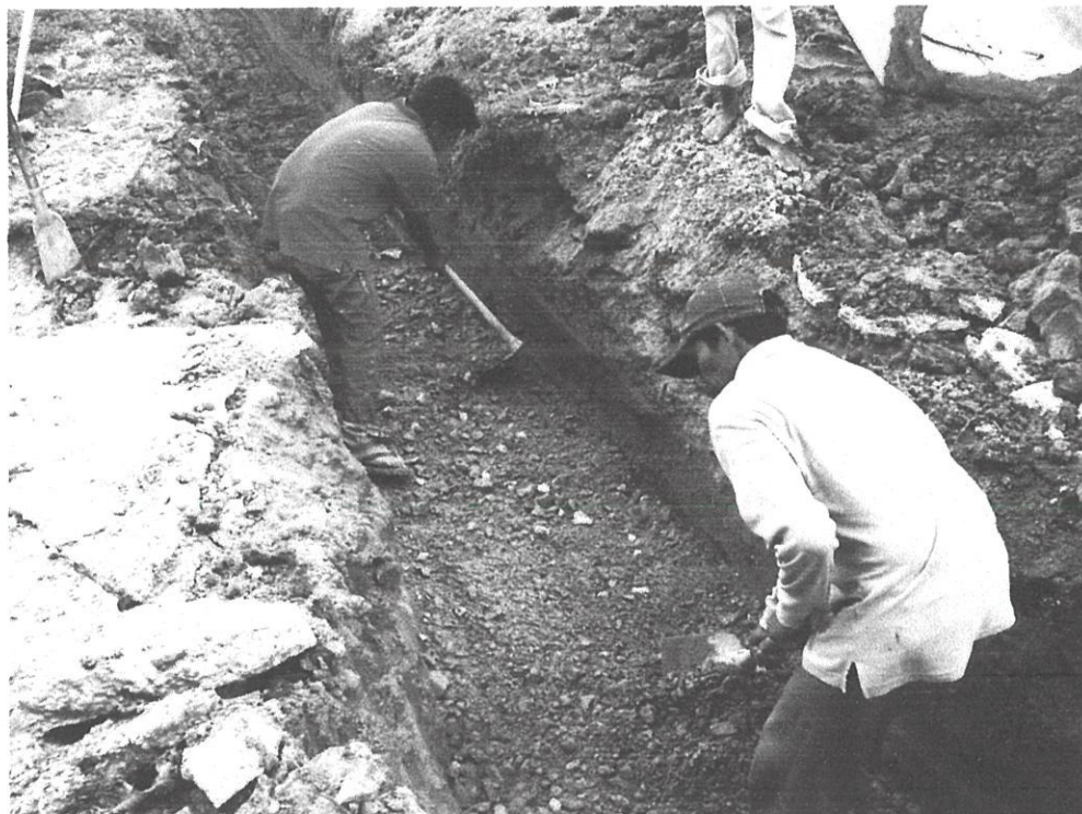
Gambarfoto 4.12: Pekerja buruh sedang meratakan dan memadatkan lapisan batu baur menggunakan cangkul.
