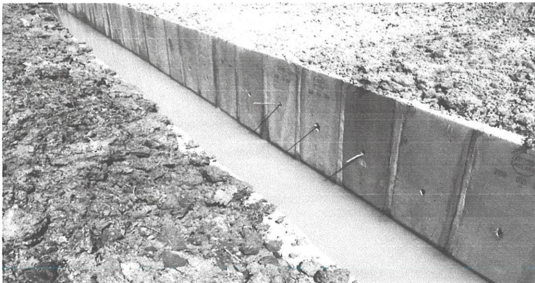
Gambarfoto 4.21: Ujian kecerunan longkang menggunakan air.
