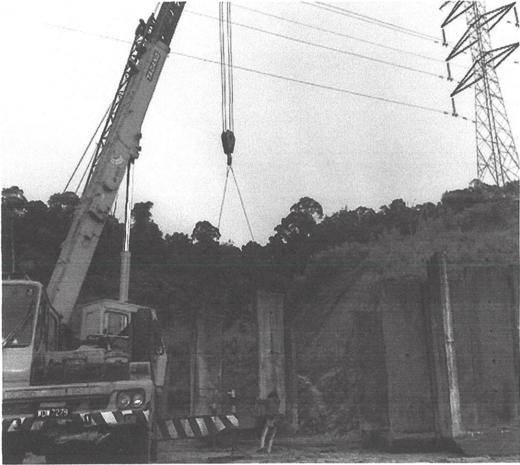
Gambarfoto 3.2.3: Kaedah mengangkat Longkang U.
