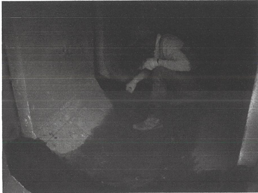
Gambarfoto 4.17: Dasar longkang yang telah siap dilepa dengan konkrit.
