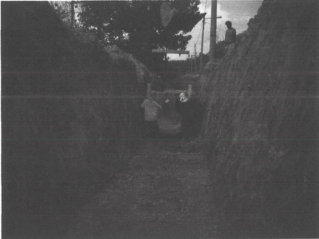
Gambarfoto 4.15: Menunjukkan bongkah longkang U yang diangkat menggunakan jentolak dan diletakkan di dalam parit.
