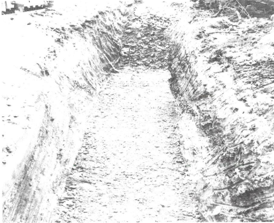
Gambarfoto 4.1.2.4: Lapisan batu baur yang telah siap dipadatkan.
