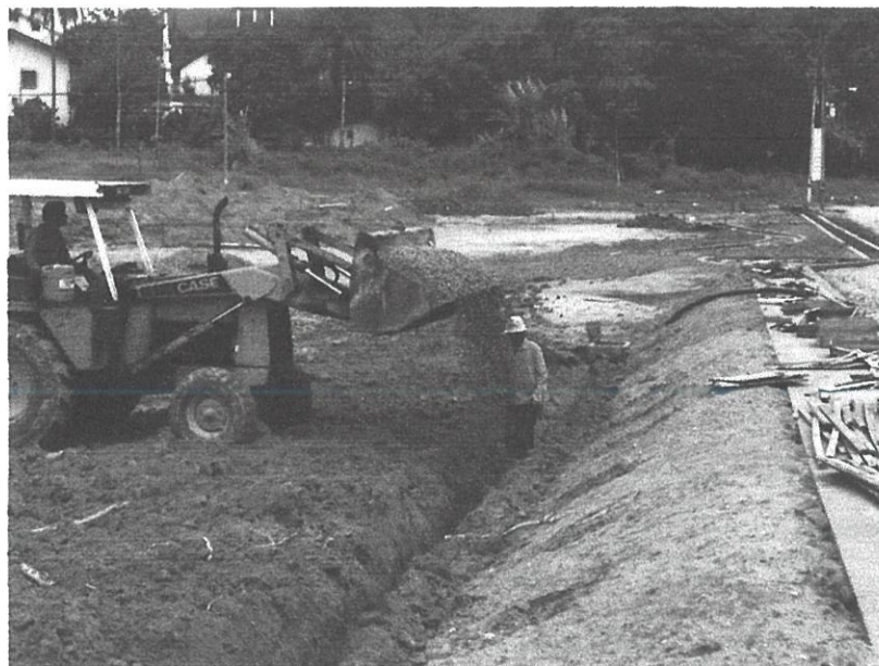
Gambarfoto 4.10: Jentolak digunakan bagi mengisi batu baur.
