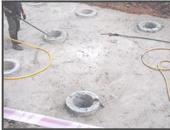
Gambarfoto 4.10: 'Spun Pile' yang sedang dibersihkan
