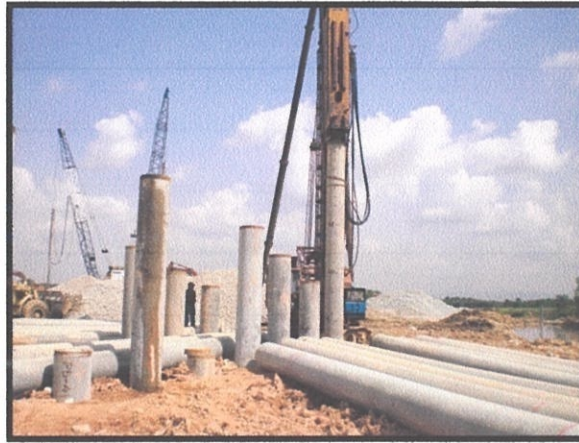
Gambarfoto 4.4: Proses membenankan cerucuk menggunakan Jek Hiraulik
