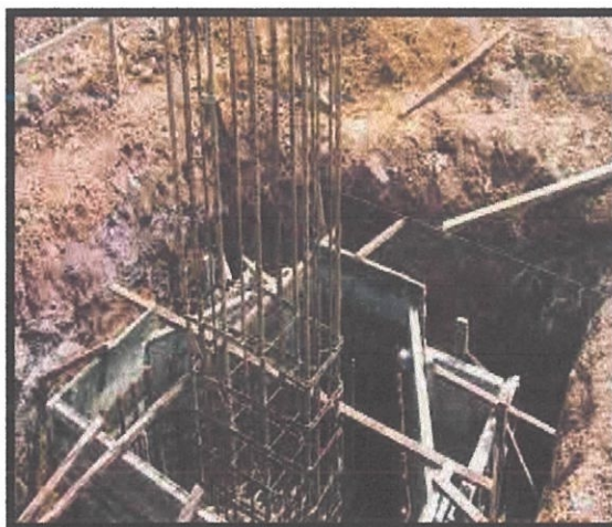
Gambarfoto 4.13: Kerja-kerja semasa pembinaan 'Pile Cap'
