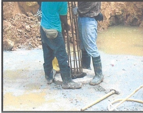
Gambarfoto 4.12: 'Pile Plug' dimasukkan ke dalam lubang 'Spun Pile'
