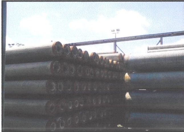
Gambarfoto 3.3: 'Spun Pile' yang telah disusun di tempat yang dikhas
