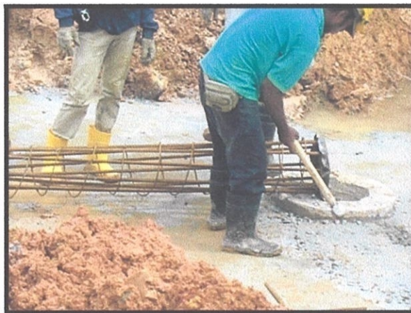
Gambarfoto 4.11: 'Plug Pile' diketuk dengan penukul
