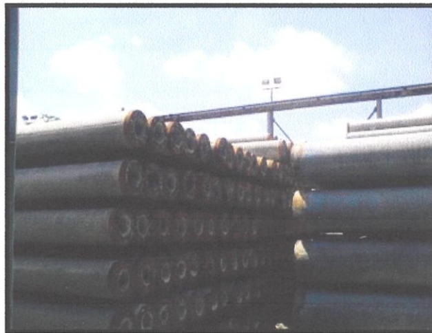
Gambarfoto 4.2: Longgokkan 'Spun Pile' di tapak bina
