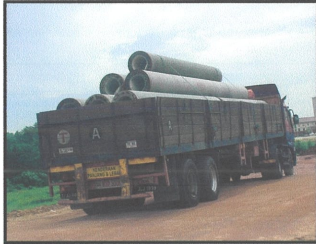
Gambarfoto 5.1: Penghantaran 'Spun Pile' dengan lori ke tapak bina
