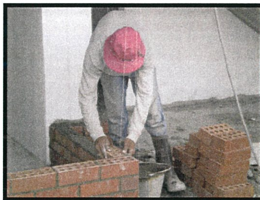
Gambar foto 3.17: Pekerja sedang mengikat bata.
