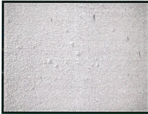
Gambar foto 3.16: Cat menggelembung
