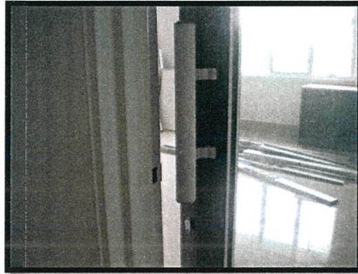
Gambar foto 3.11: Lubang penyelak tidak sama dengan penyelak
