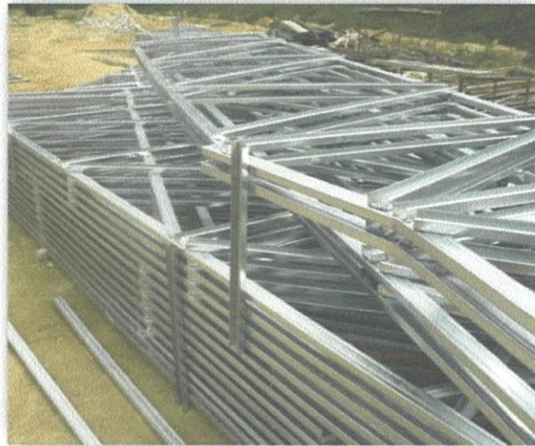
Gambar Rajah 3.1: Kekuda yang telah siap dibina.
