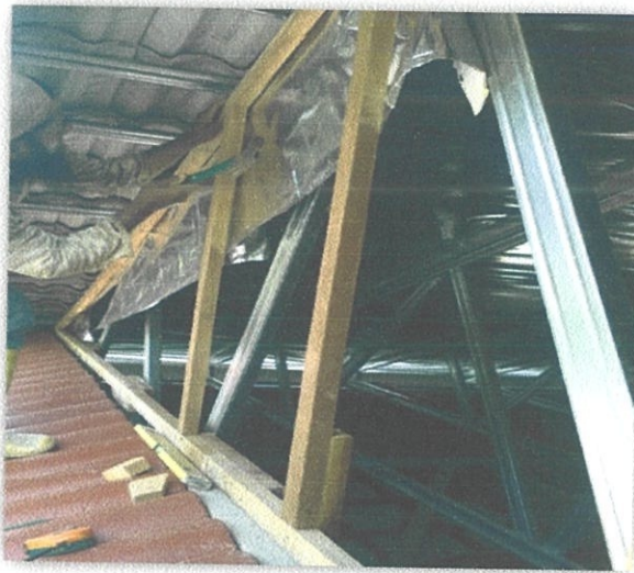
Gambar Rajah 3.12: Pemasangan siling.
