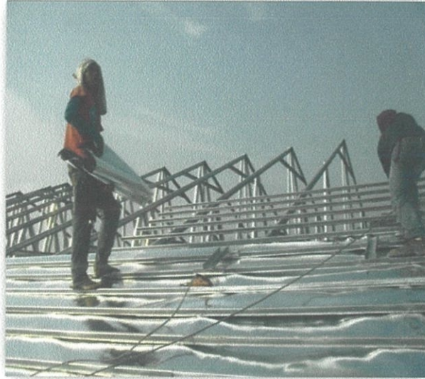
Gambar Rajah 3.7: Kepingan aluminium diapit di bawah besi merintang.
