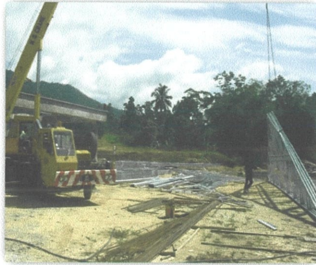
Gambar Rajah 3.3: Kekuda dinaikkan ke atas bumbung dengan bantuan kren.
