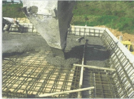
Gambar Rajah 3.18: kerja-kerja konkrit.
