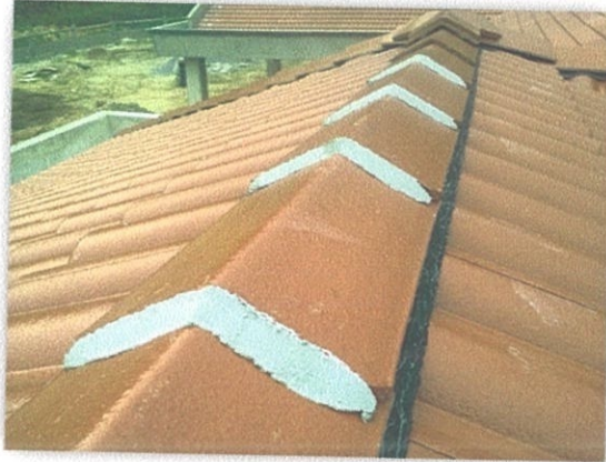
Gambar Rajah 3.9: Lepaan simen nisbah 1:3 pada atap rabung.
