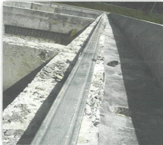
Gambar Rajah 3.4: Besi keluli merintang dipasang pada rasuk bumbung.
