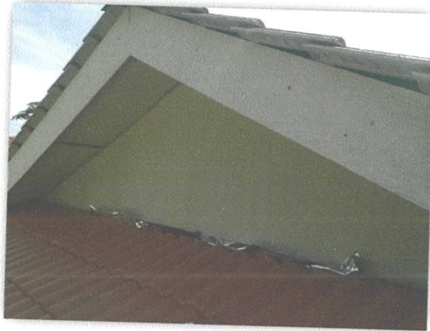
Gambar Rajah 3.13: Siling siap dipasang.
