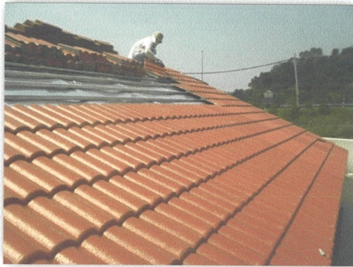
Gambar Rajah 3.8: kerja-kerja menyusun penutup bumbung berbentuk ‘S’.
