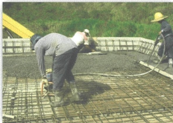
GambarRajah 3.19: Memampatkan konkrit.
