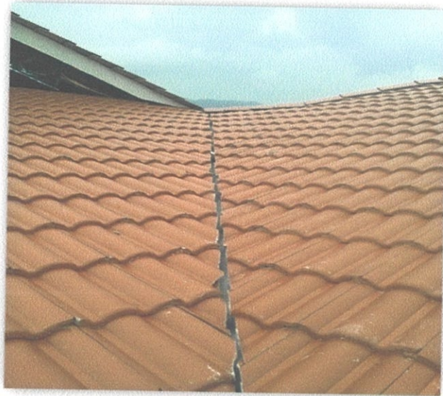
Gambar Rajah 3.11: Atap di bahagian lurah akan dipotong.
