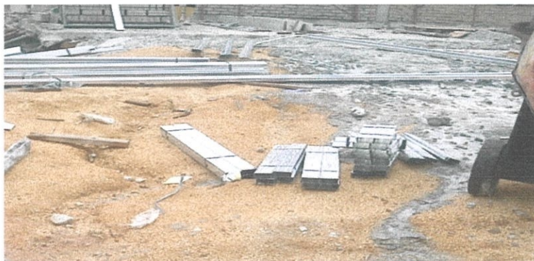
Gambar 3.2 : Besi keluli disusun mengikut saiz Foto Kredit: Ahmad Adzim (5 Dis 2011)
