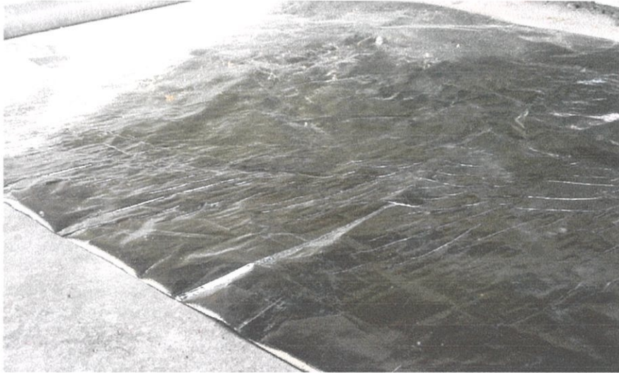
Gambar 3.7 :Jenis 'sunfoil' yang digunakan Foto Kredit: Ahmad Adzim (12 Dis 2011)
