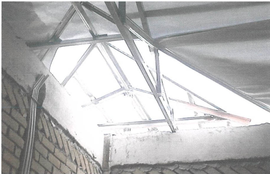
Gambar 3.13 :Menunjukkan tapak pemasangan valley gutter
