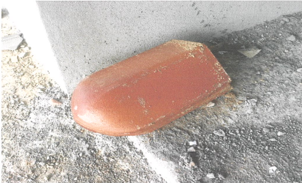
Gambar 3.19 :Jenis hujung perabung yang digunakan Foto Kredit: Ahmad Adzim (12 Dis 2011)
