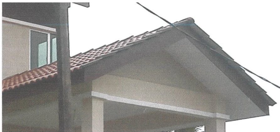
Gambar 3.12 : 'fascia board' telah dicat Foto Kredit: Ahmad Adzim (22 Nov 2011)
