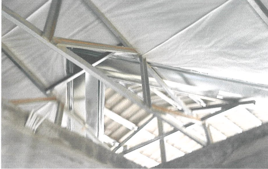
Gambar 3.14 : 'valley gutter' telah siap dipasang Foto Kredit: Ahmad Adzim (29 Nov 2011)
