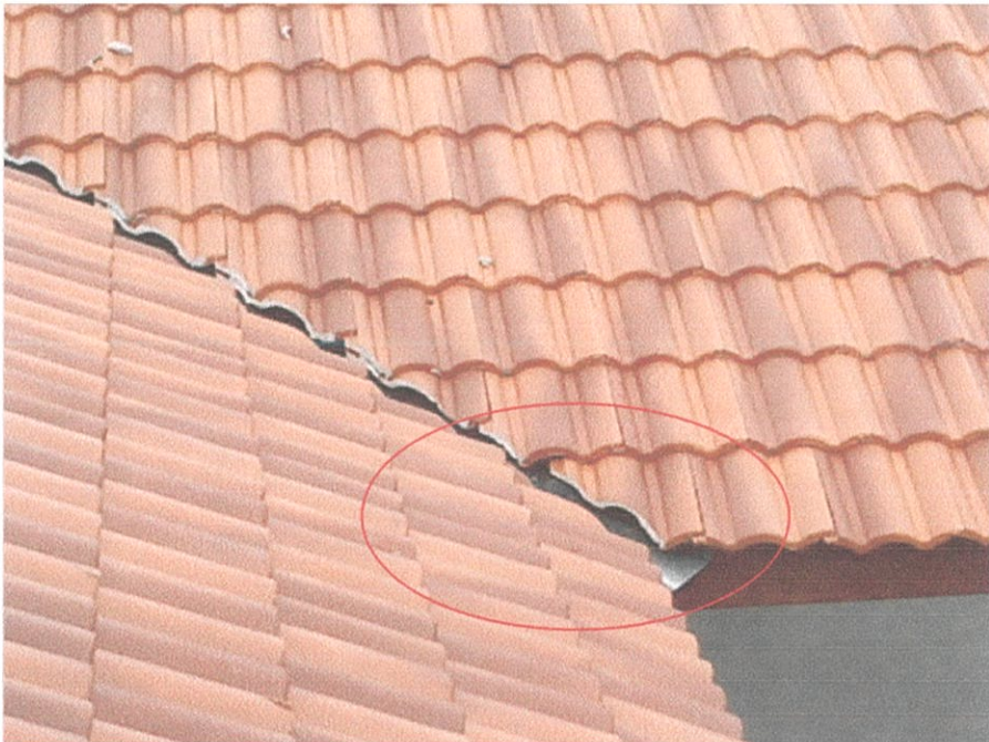
Gambar 3.15 : Dalam bulatan, lebih genting telah dipotong Foto Kredit: Ahmad Adzim (27 Jan 2012)
