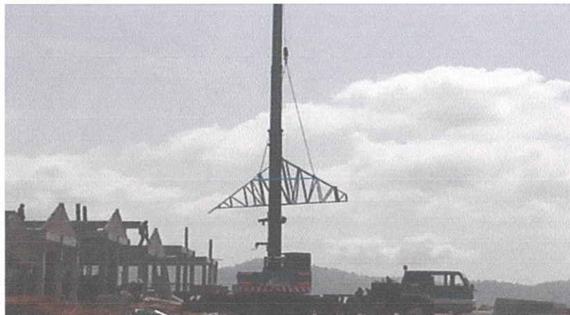
Gambar 3.5 :Menunjukkan kren sedang mengangkat kekuda Foto Kredit: Ahmad Adzim (26 Dis 2011)
