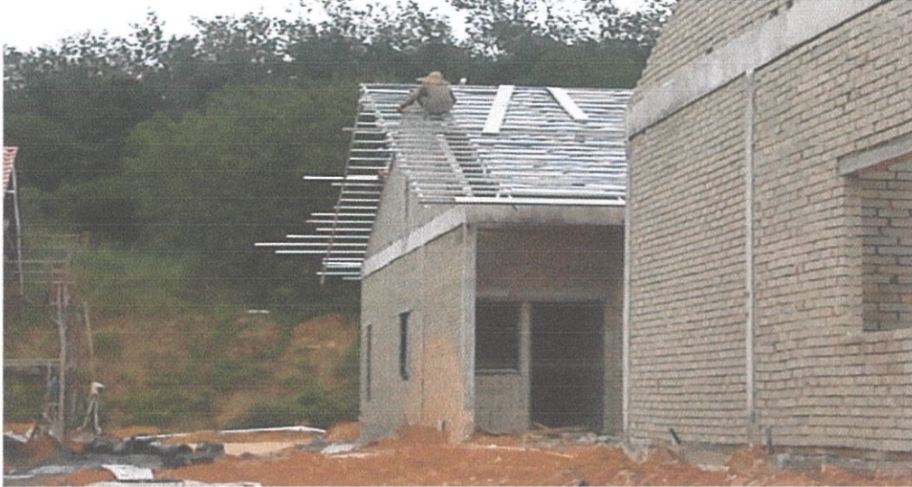
Gambar 3.11 :Menunjukkan pekerja sedang memotong lebihan 'batten' Foto Kredit: Ahmad Adzim (5 Dis 2011)
