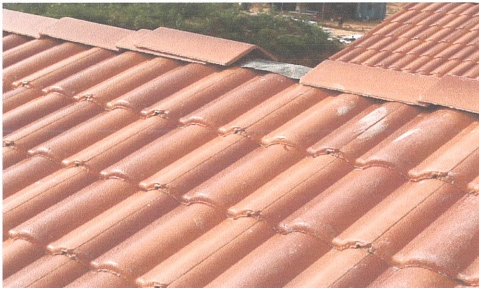
Gambar 3.18 :Jenis perabung yang digunakan Foto Kredit: Ahmad Adzim (12 Dis 2011)
