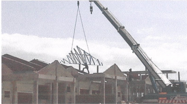
Gambar 3.6 :Kekuda disambut oleh pekerja Foto Kredit: Ahmad Adzim (26 Dis 2011)
