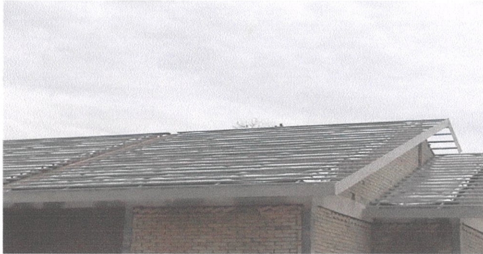
Gambar 3.10 :Menunjukkan ' batten ' dan ' facia board ' telah siap dipasang Foto Kredit: Ahmad Adzim (5 Dis 2011)
