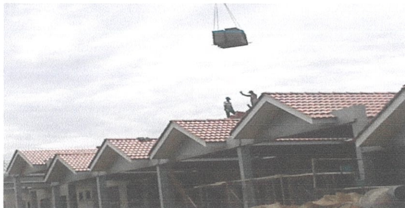
Gambar 3.17 :Menunjukkan kren sedang mengangkat pallet yang berisi kepingan genting Foto Kredit: Ahmad Adzim (21 Dis 2011)
