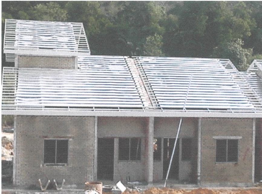
Gambar 3.8 :Menunjukkan sunfoil ditindih batten dan di skru Foto Kredit: Ahmad Adzim (12 Dis 2011)
