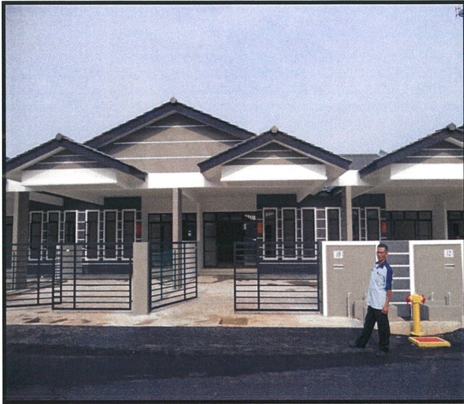
Gambar 3.2.3: Kemudahan pili bomba di bahagian hadapan rumah.
