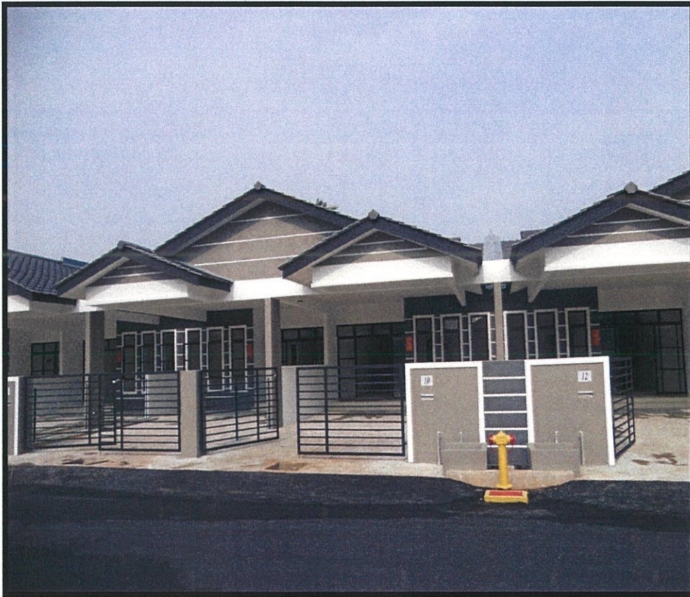
Gambar 3.2.1: Pandangan hadapan rumah teres yang telah siap dibina, Tanjung Lumpur.
