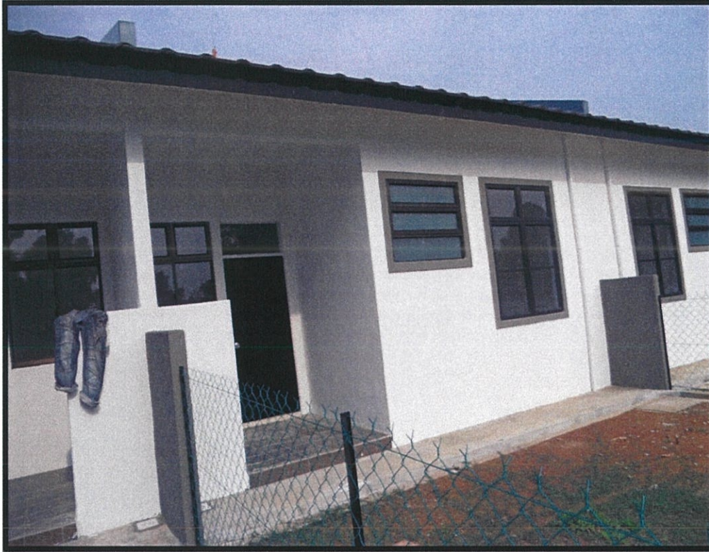
Gambar 3.3.5 : Bahagian belakang rumah menunjukkan ruang pengudaraan.
