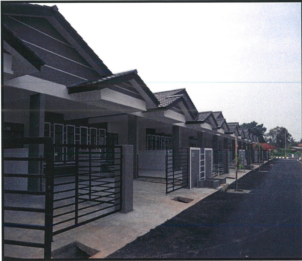
Gamabar 3.2.2: Longkang yang tidak mempunyai penutup, Tanjung Lumpur.
