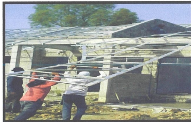
Rajah 4.18 Kekuda bumbung keluli ditolak ke atas
