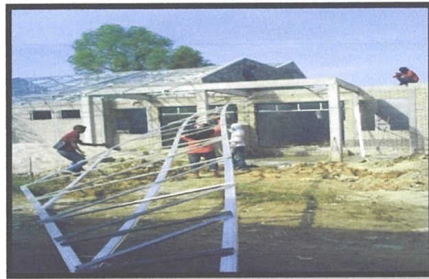
Rajah 5.1 Mengangkat Kekuda Bumbung Kekuli
