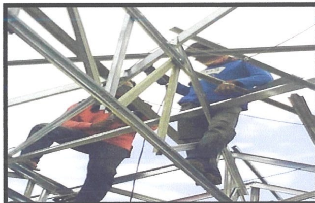
Rajah 4.21 Pemasangan menggunakan skru
