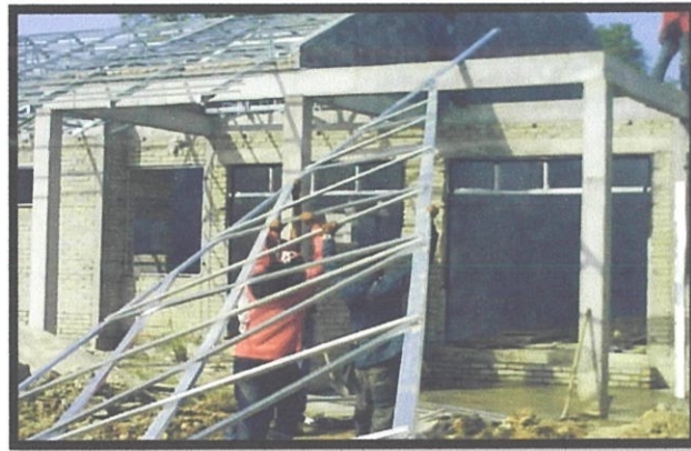
Rajah 4.17 Kekuda bumbung diletak di atas kerangka bumbung
