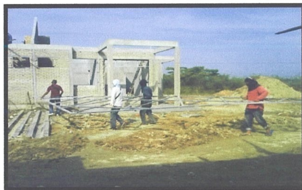
Rajah 4.16 Kekuda bumbung dibawa ke tapak bina
