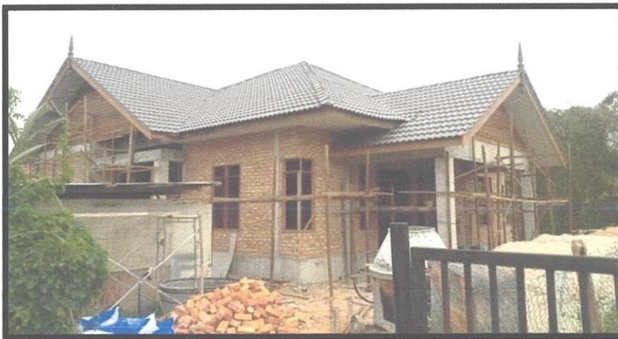
Photo 2.4 1 storey bungalow, kampung Padang Machang, 70 % in progress
