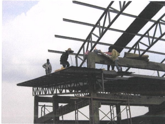
Foto 11: kerja-kerja pemasangan atap
