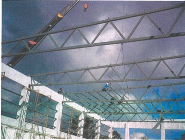
Foto 6 : kerja-kerja menaikkan dan pemasangan “purlin”
