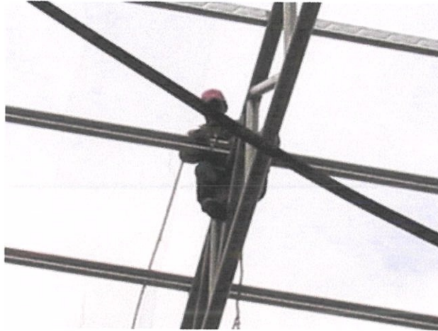
Foto 7: kerja-kerja pemasangan “chicken netting”
