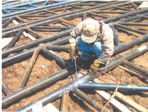
Foto 2 : kerja-kerja penyambungan kekuda bumbung
