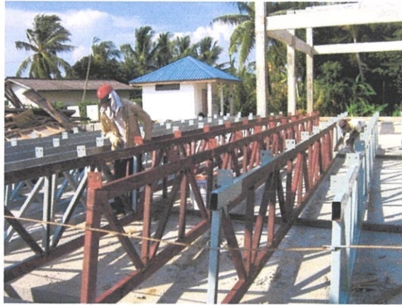
Foto 3:kerja-kerja mengecat kekuda bumbung
