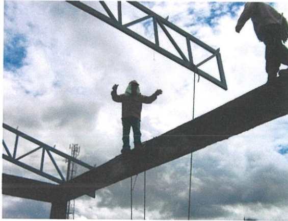
Foto 5 : kerja-kerja pemasangan kekuda bumbung
