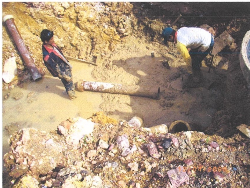
Gambar foto 4.3.1.1 Kerja pengorekan tanah
