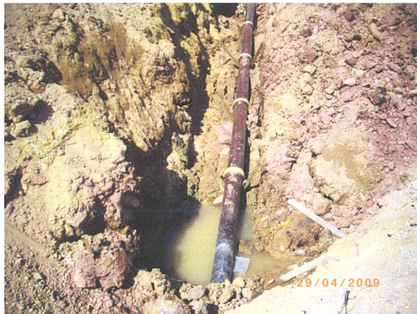
Gambar foto 4.3.3.1 Paip najis bengkok semasa kerja pemasangan
