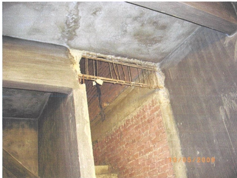
Gambar foto 4.3.5.1 Besi daripada rasuk di ruang tangga
