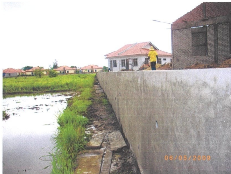
Gambar foto 4.4.1.1 Pembinaan tembok penahan runtuh
