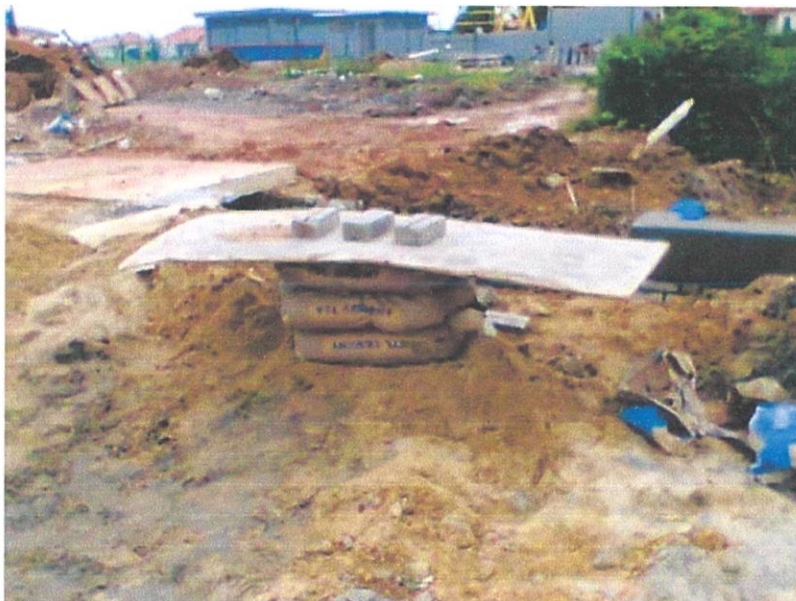
Gambar foto 4.5.4.1 Simen ditutup dengan papan lapis
