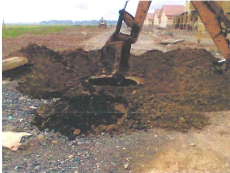
Gambar foto 4.3.2.1 Kerja pengorekan untuk aras tudung lurang
