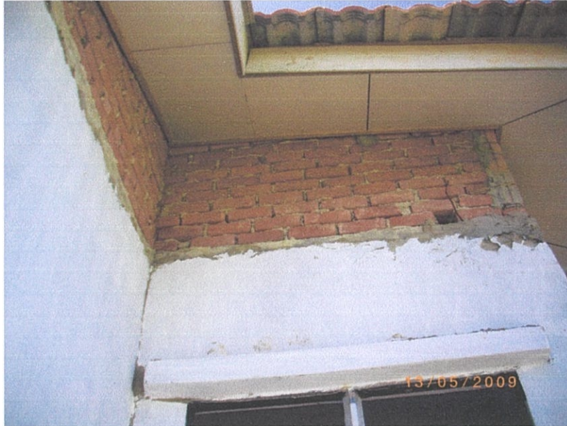
Gambar foto 4.2.3.1 Ikatan bata belum diplaster
