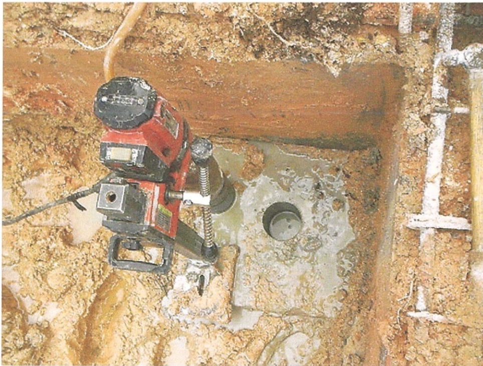
Gambar foto 5.8 Konkrit yang siap ditebuk akan dikeluarkan.
