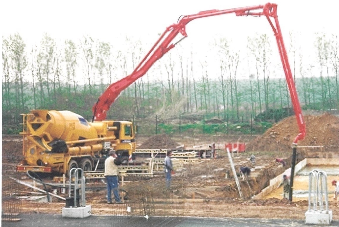
Gambar foto 3.4 Kerja-kerja konkrit dapat dijalankan dengan lebih cepat menerusi kaedah pam terus.
