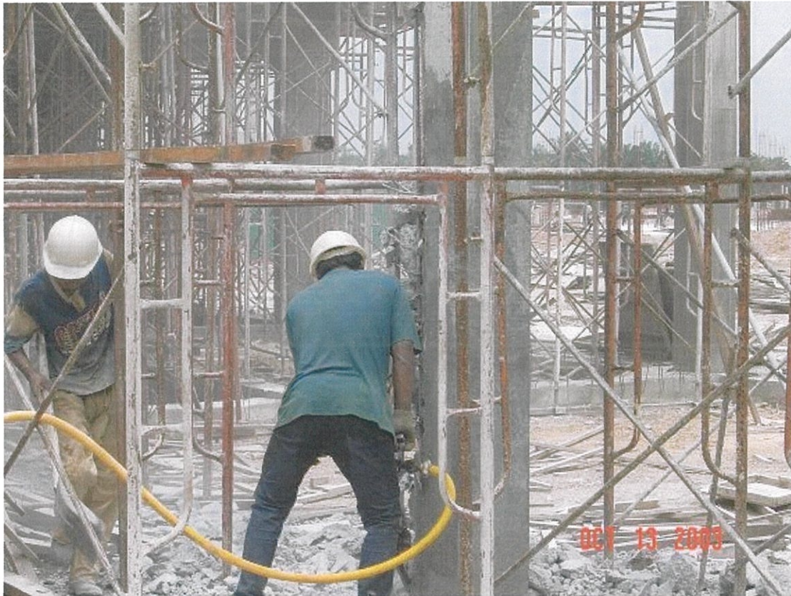
Gambar foto 5.1 Kerja-kerja pemecahan semula konkrit terpaksa dilakukan akibat kecuaiian semasa kerja-kerja konkrit dijalankan.
