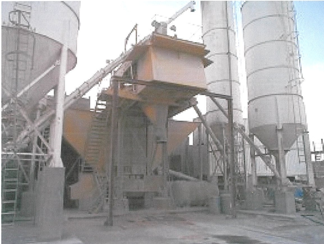
Gambar foto 3.1 'Batching Plant' atau loji penyediaan konkrit.
