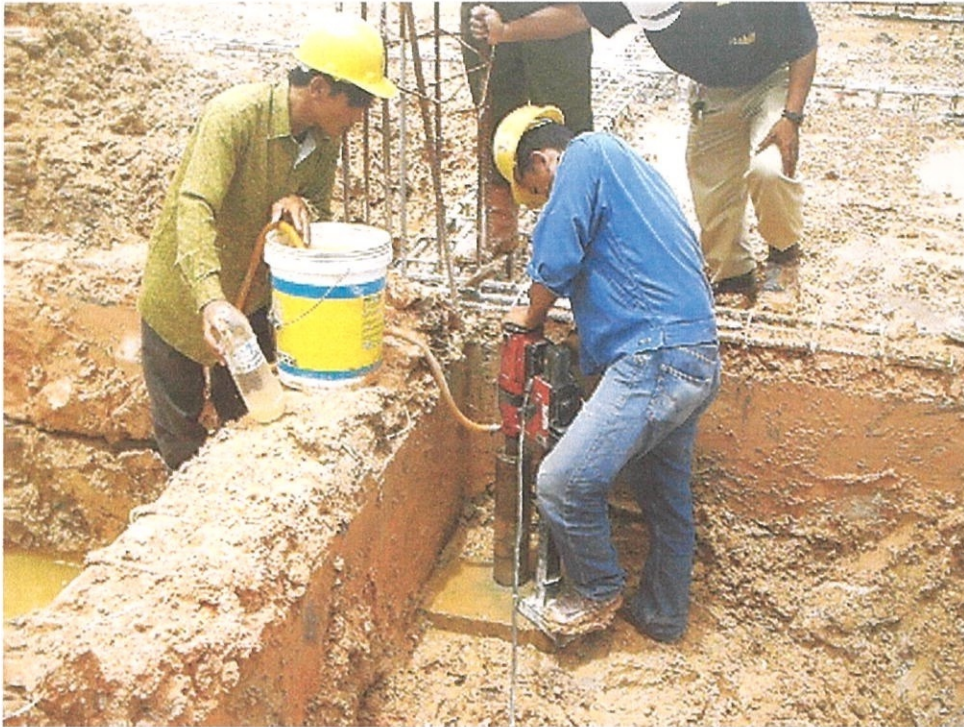
Gambar foto 5.7 Kerja-kerja penebukan konkrit dilakukan secara menegak atau 'vertical'. Konkrit akan ditebuk sedalam 6 inci atau lebih kurang 150mm.
