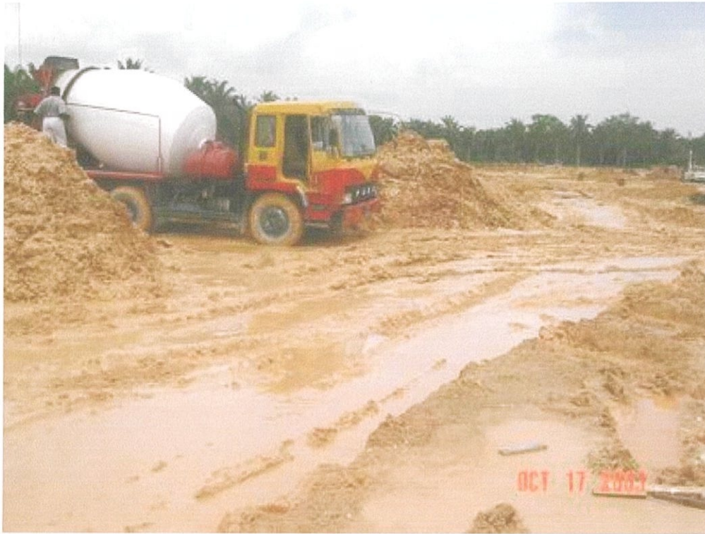
Gambar foto 5.3 Lori yang membawa bancuhan konkrit seringkali tersangkut akibat struktur tanah yang terlalu lembik.
