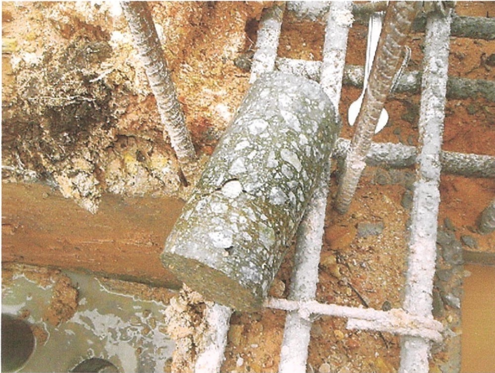
Gambar foto 5.9 Konkrit yang telah ditebuk ini berukuran 150mm dan berdiameter 50mm. Konkrit ini akan diawet selama 2 hari sebelum ujian kekuatan dijalankan sekali lagi.
