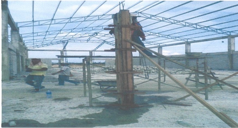
Gambar 3.7: Contoh kotak acuan konkrit menggunakan papan lapis.
