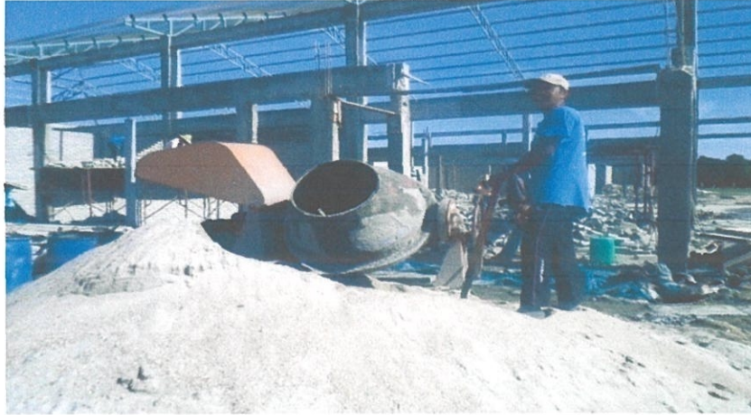
Gambar 3.8: Mesin konkrit bancuh sendiri di tapak binaan.
