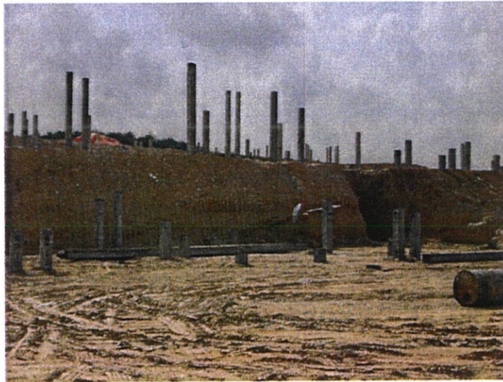
Rajah 4.2 Pemotongan cerucuk
