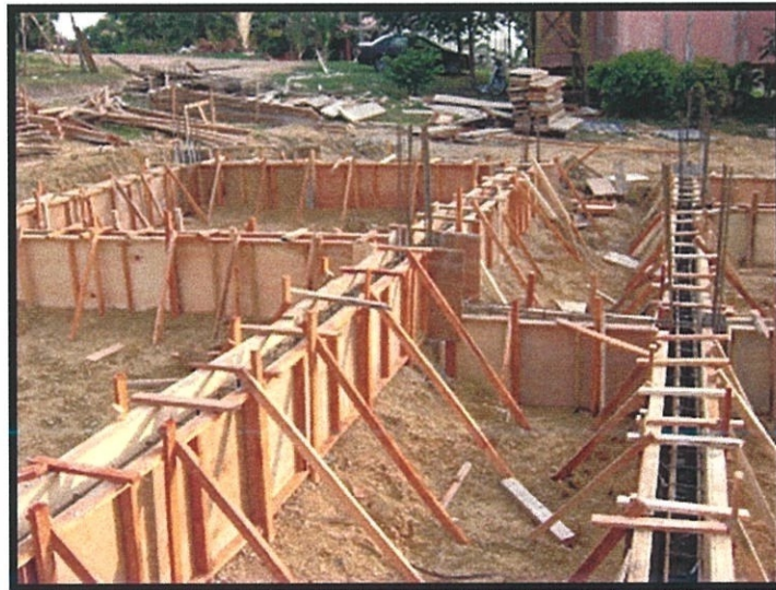
Gambarfoto 3.2 : kotak bentuk yang sedia untuk dituang konkrit
