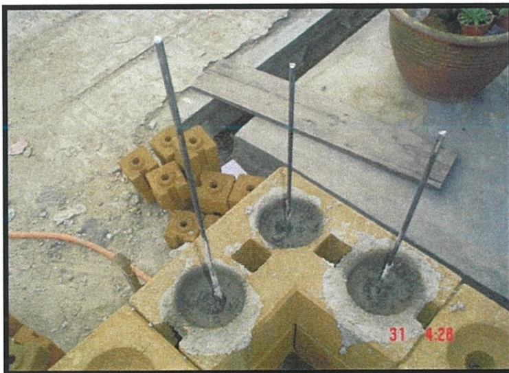
Gambarfoto 3.8 : penyambungan bata 'L'
