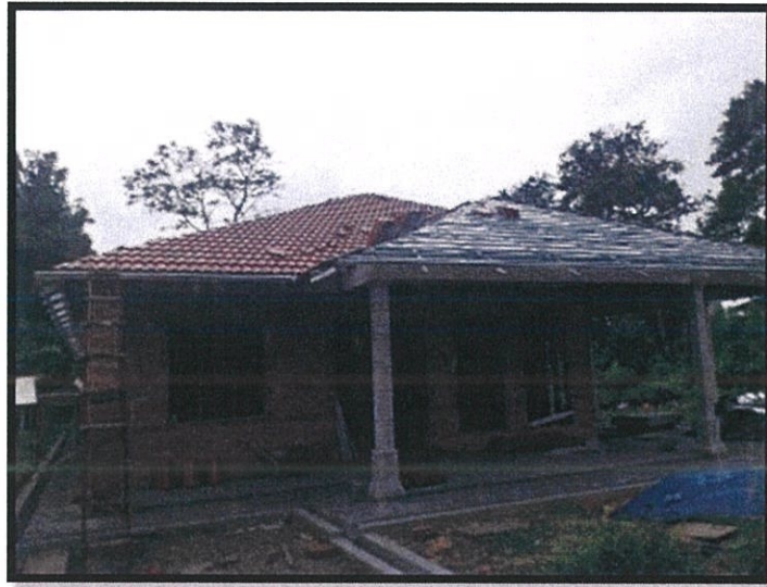
Gambarfoto 3.6 : Pemasangan atap genting
