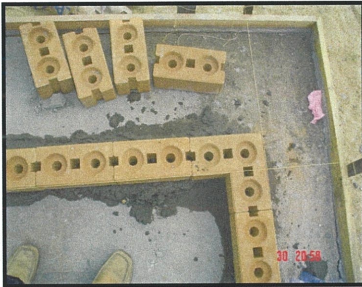
Gambarfoto 3.7 : penyambungan bata asas IBS
