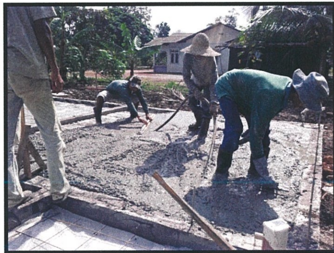
Gambarfoto 3.4 : kerja-kerja meratakan konkrit
