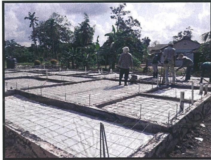
Gambarfoto 3.3: lantai yang belum dikonkrit
