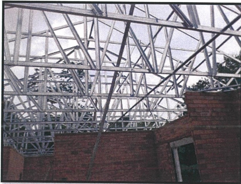
Gambarfoto 3.5 : kerangka bumbung daripada keluli
