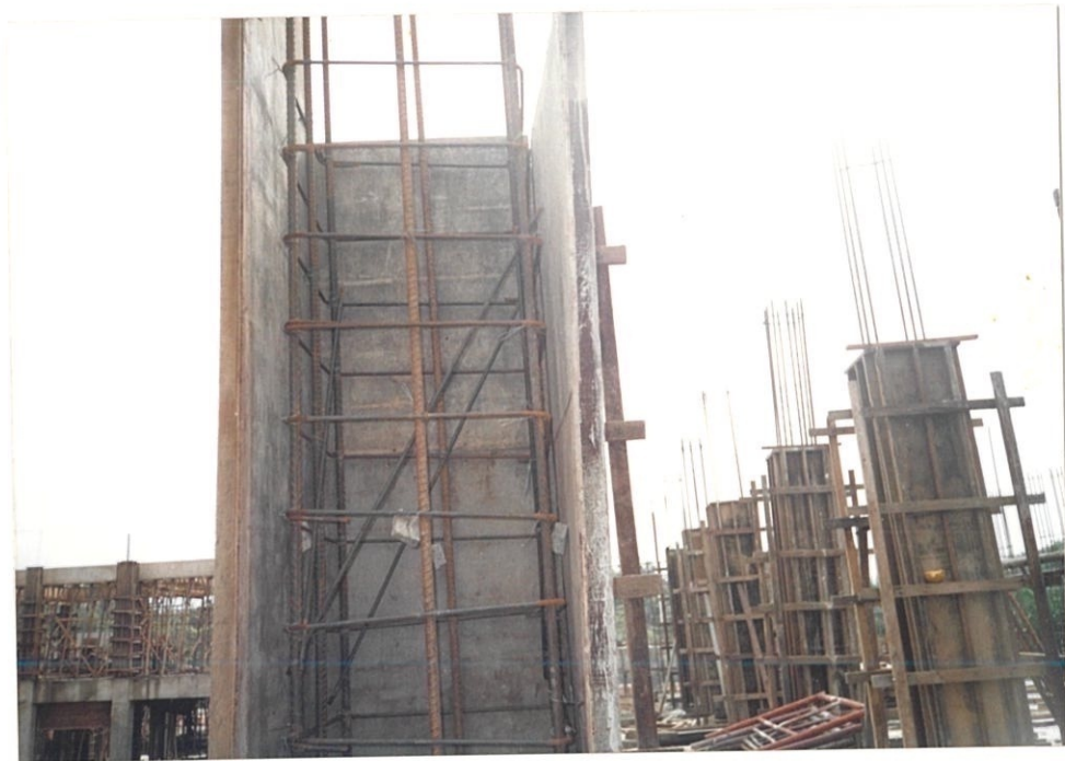
Gambar 3.2: Tetulang keluli sederhana (mild steel) dan keluli tahanan tinggi (high tensile steel) yang dipasang dalam acuan tiang
