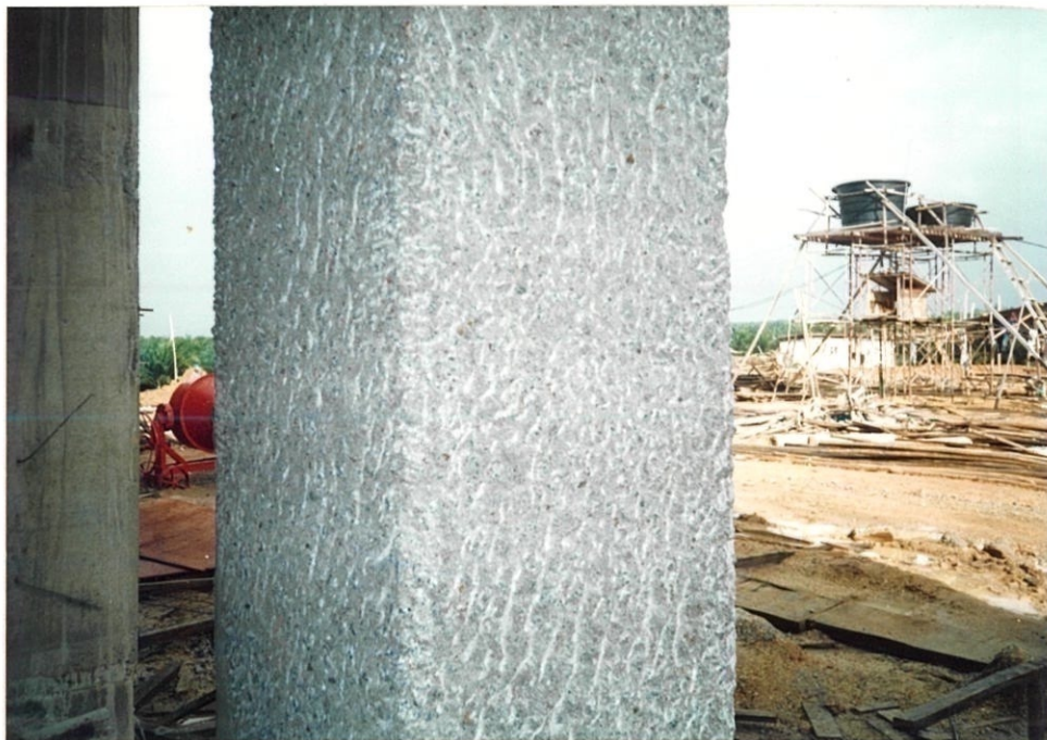
Gambar foto 6.2: Struktur tiang yang di ketuk supaya lurus dengan menggunakan tukul dan pahat sebelum di plaster.
