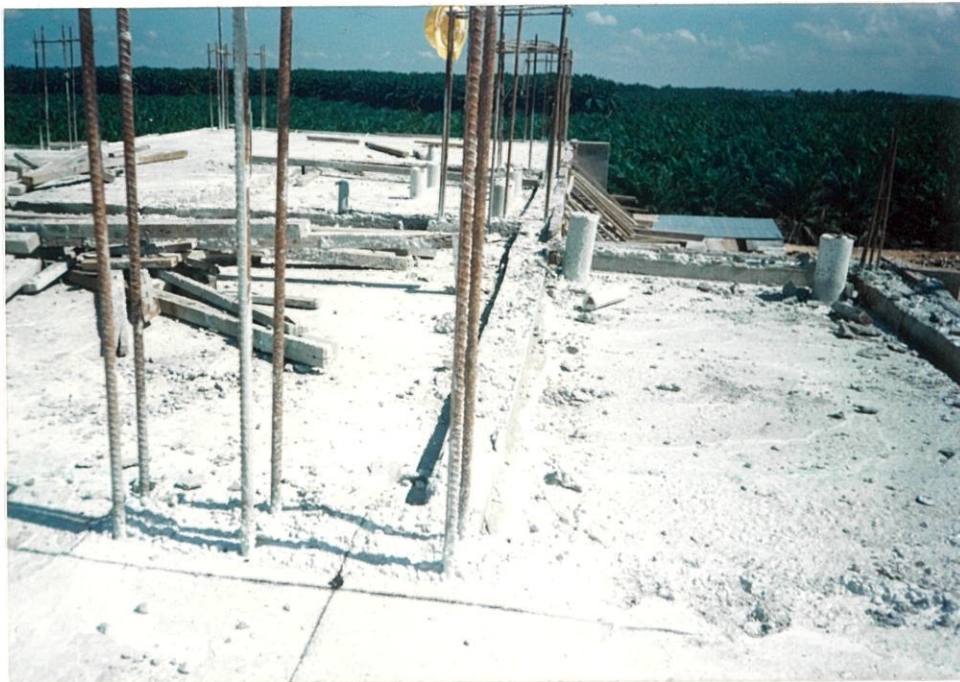
Gambar 4.6: Menunjukkan dakwat hitam yang digunakan untuk menanda kedudukan tiang ke tiang supaya selari.
