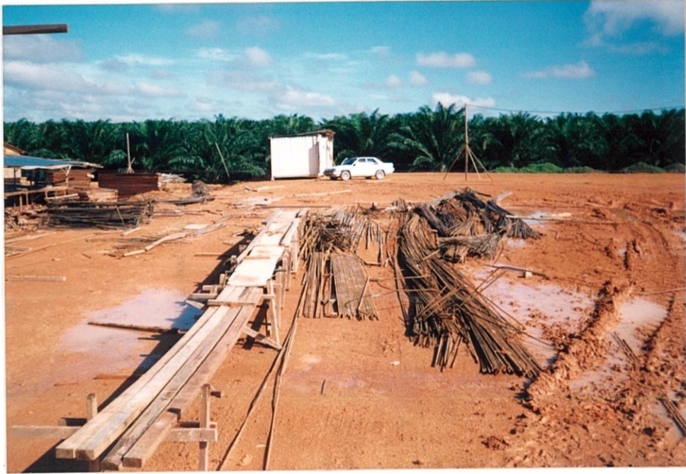
Rajah 3.7 : Tempat membengkok besi tetulang secara manual.
