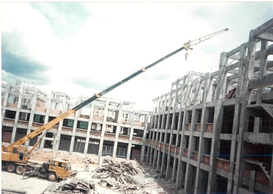
Gambar 4.0: Mobil kren jenis tadano yang digunakan ditapak bina
