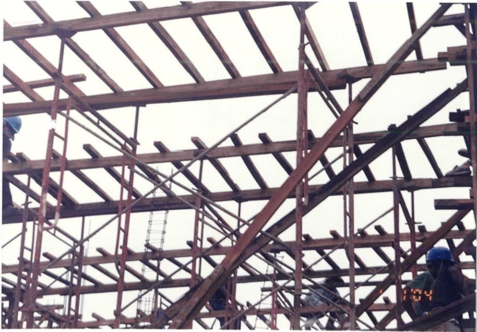
Foto 4.5 : peranca dipasang pada kayu gelegar sementara sebagai penyokong rasuk
