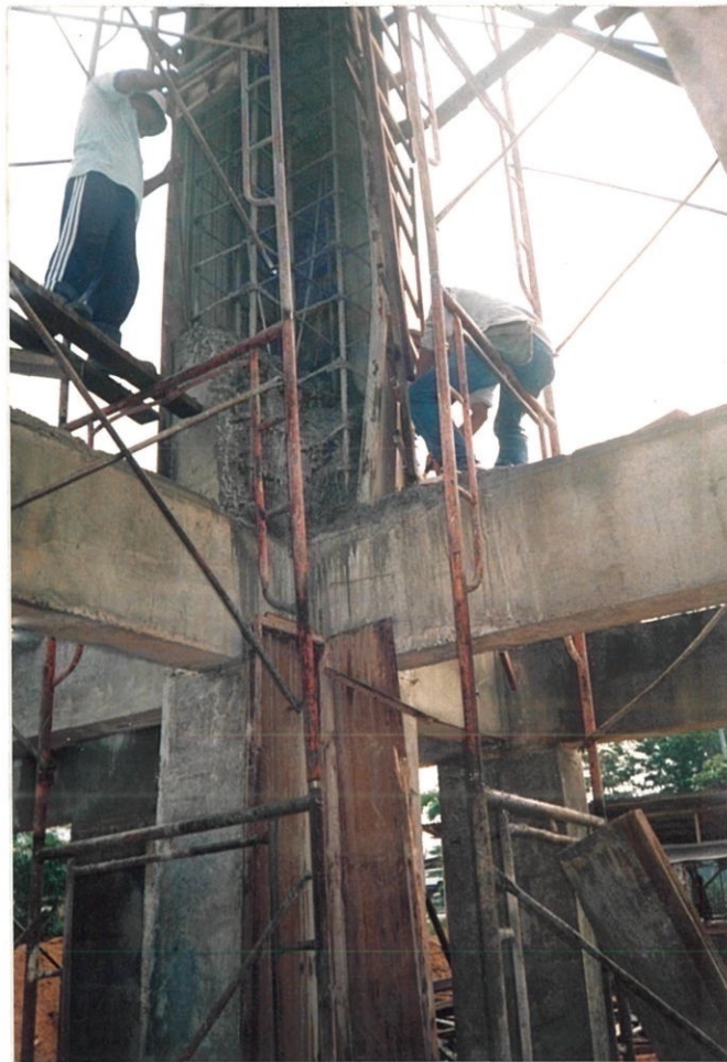
Gambar 6.1: Kotak acuan tiang yang pecah semasa di konkrit
