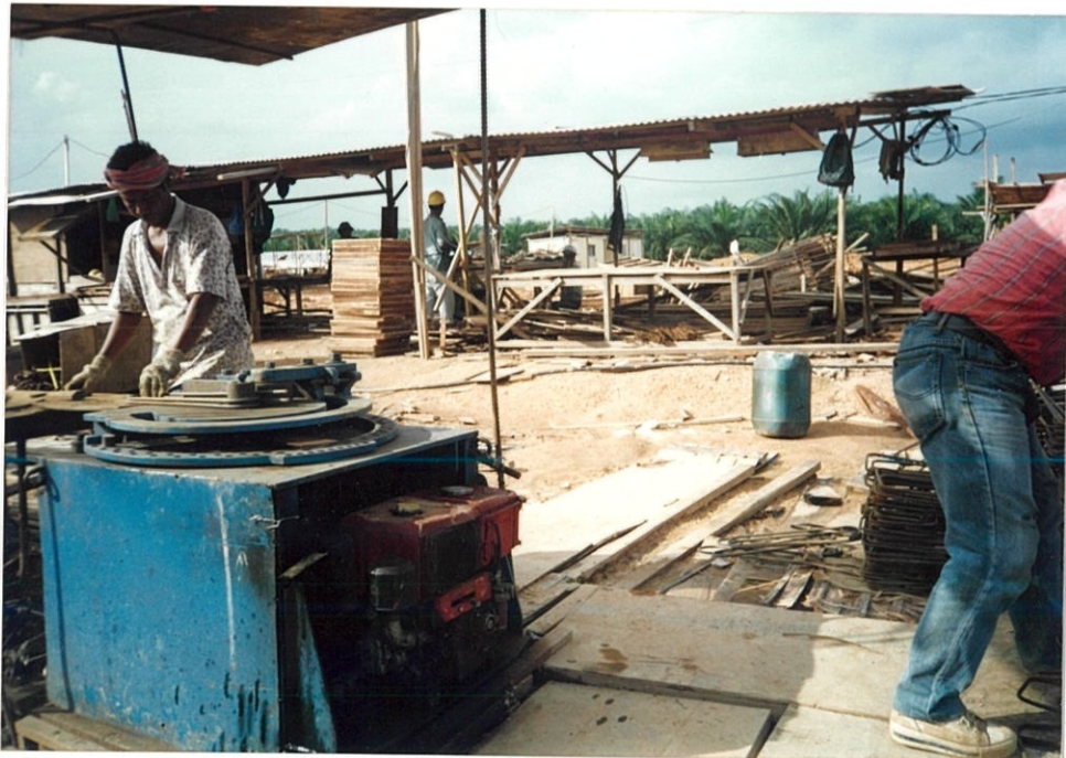
Gamba 3.6 : Kerja – kerja pembengkokkan besi tetulang dengan menggunakan mesin
