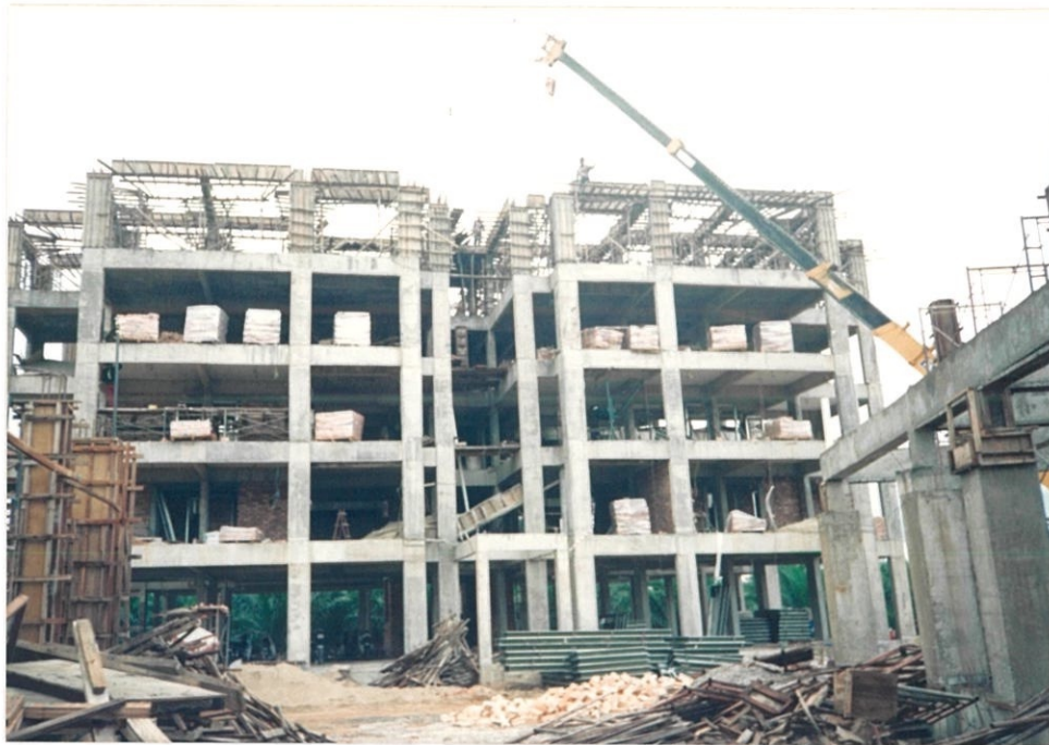
Gambar 4.17 : Pemasangan acuan pada bahagian kiri dan kanan pelantar rasuk.
