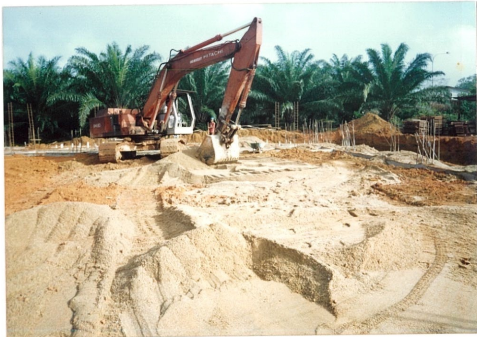
Gambar 4.2 : Excavator jenis Hitachi di gunakan ditapak bina S.K.Tok Bak
