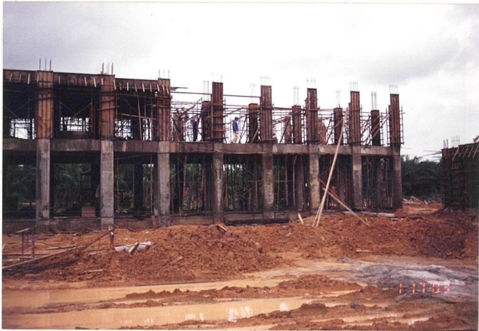
Gambar 4.10: Pemasangan kayu soffit yang merentangi tiang ke tiang untuk memastikan kotak acuan tiang selari.
