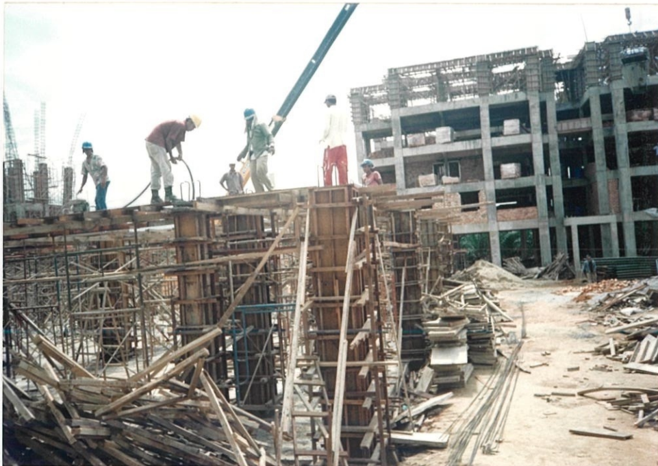
Gambar foto 4.14 : Kerja penggetaran (vibrator) pada struktur tiang konkrit bertetulang dengan menggunakan mesin penggetar konkrit.
