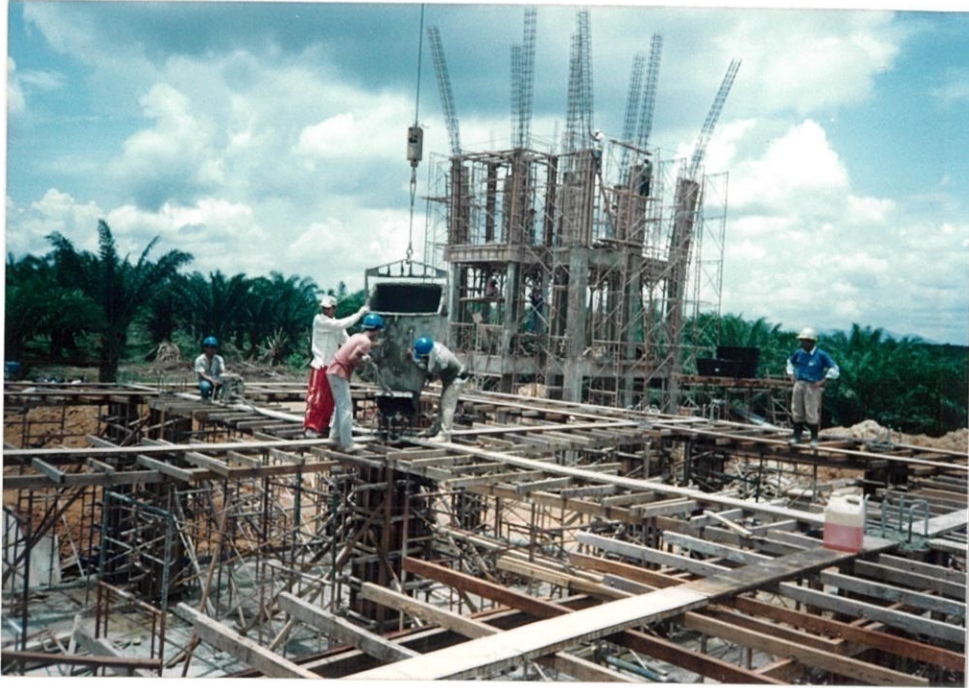
Gambar foto 4.13 : Kerja-kerja konkrit ditapak bina yang di jalankan menggunakan langkau dan di angkut dengan kren.
