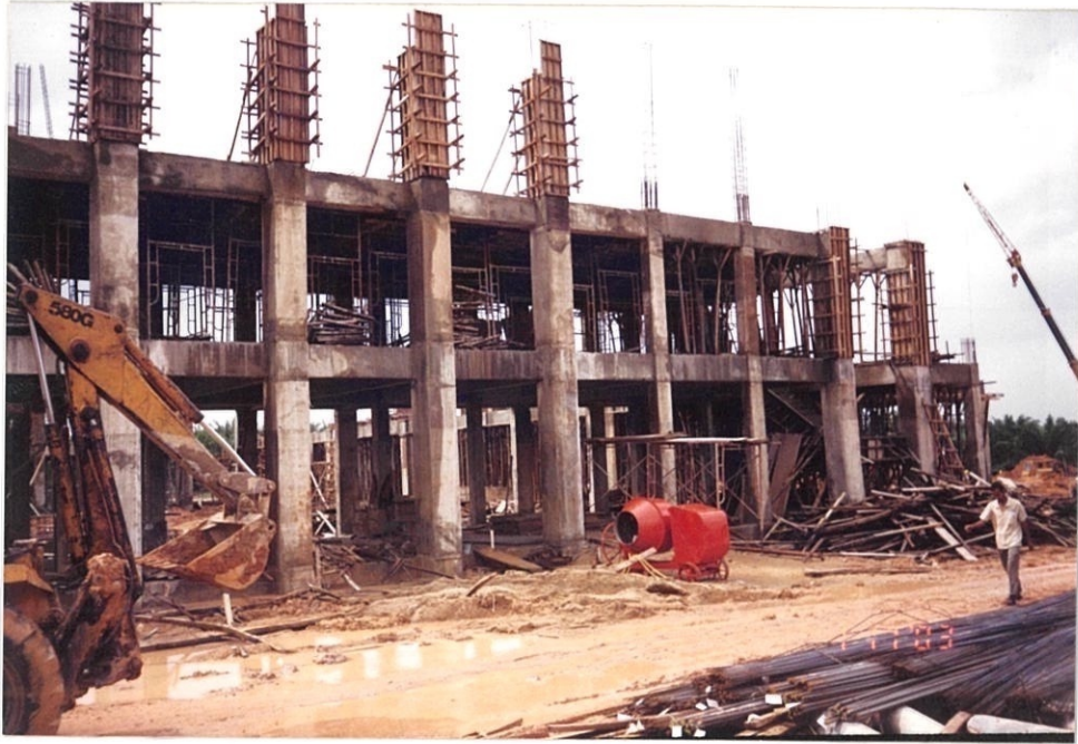
Gambar foto 4.9: Menunjukkan kaedah penumpangan sementara bagi pemasangan acuan tiang
