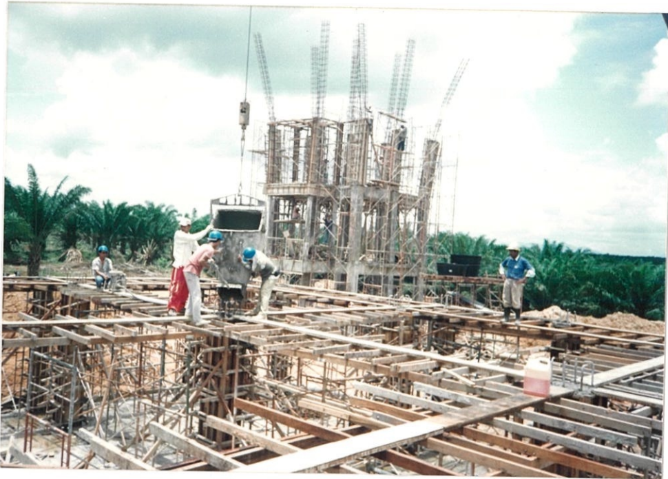
Gambar 3.5: Kerja – kerja penuangan konkrit dengan menggunakan kren dan langkau muatan 0.28m 3 .
