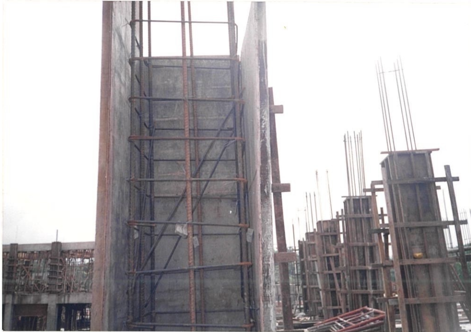
Gambar 4.8: Menunjukkan pemasangan kotak acuan untuk struktur tiang
