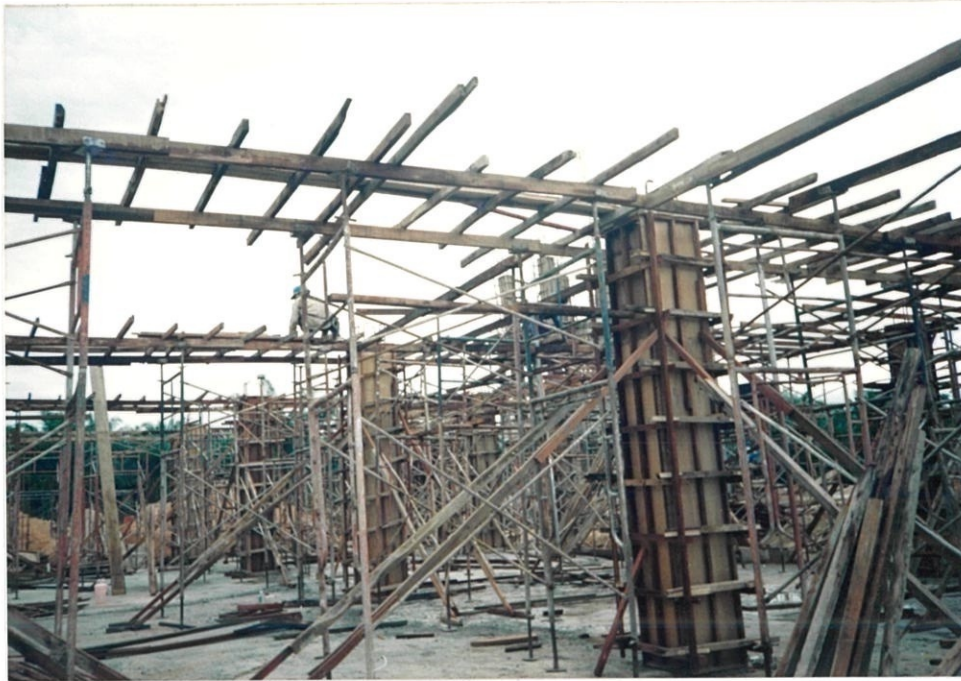
Gambar 4.16 : Pemasangan gelegar sementara untuk pembinaan rasuk.
