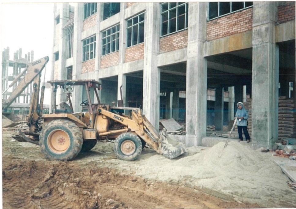
Gambar 4.1 : Backhoe yang digunakan ditapak bina.
