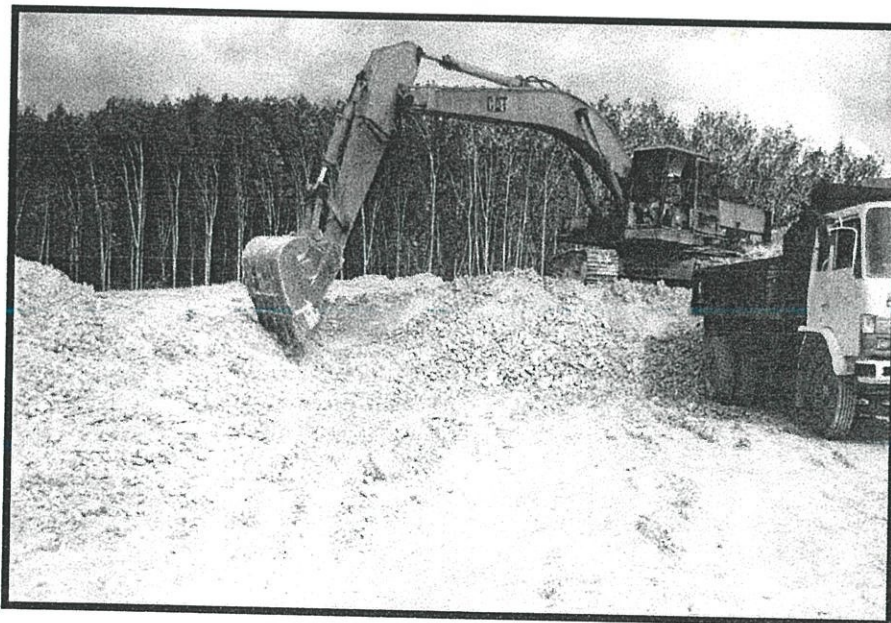
Gambar Foto 4.11 : Jentera Pengorek sedang melakukan kerja pengorekan
