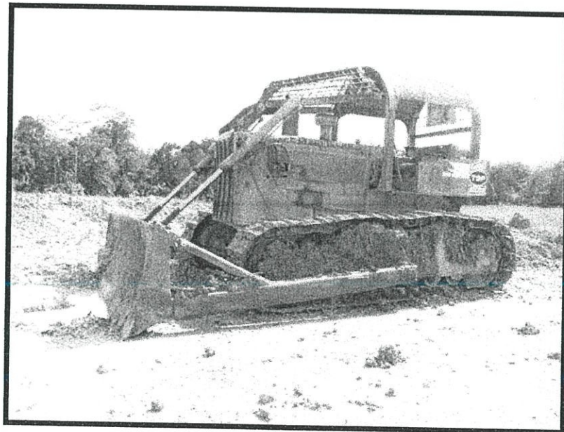
Gambar Foto 3.1 : Buldozer
