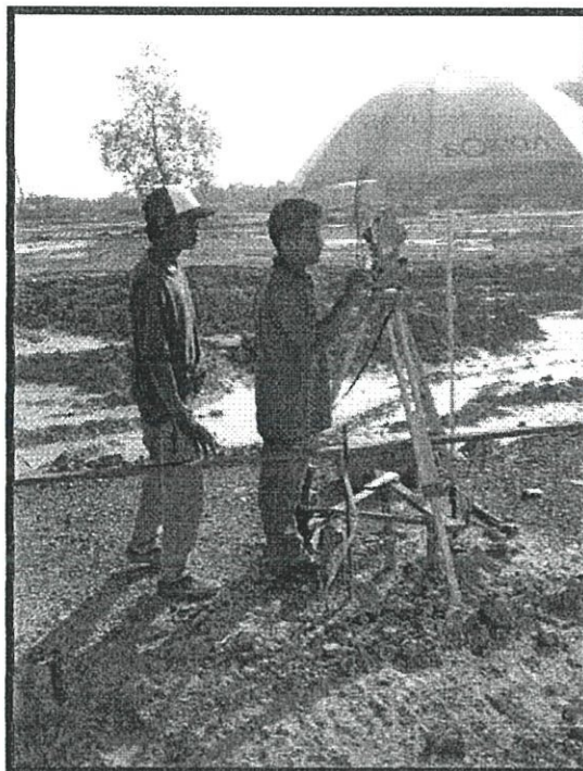
Gambar Foto 4.7 : Surveyor sedang melakukan kerja 'setting out'
