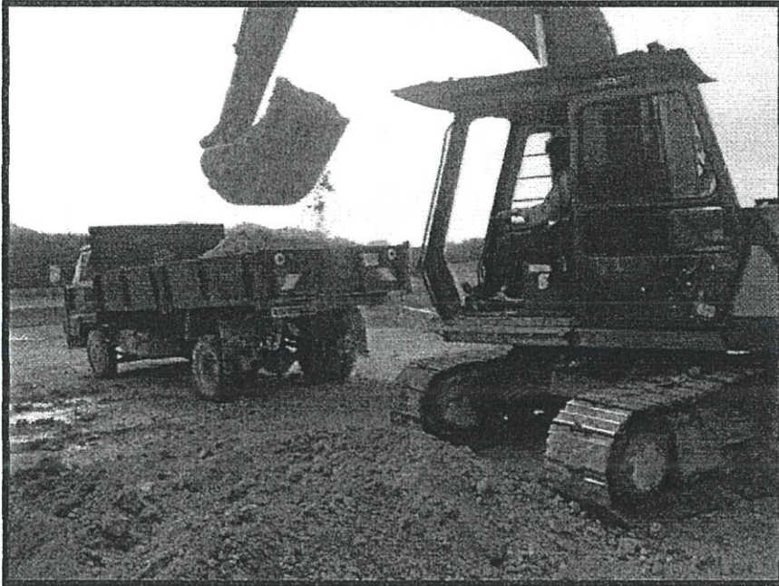
Gambar Foto 4.12 : Jentera Pengorek sedang memasukkan tanah ke dalam lori
