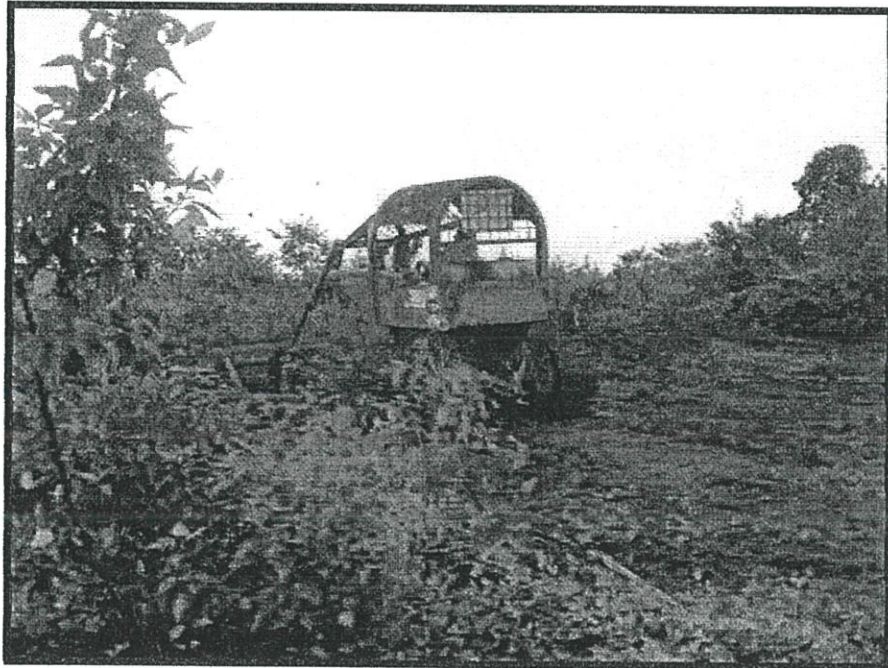
Gambar Foto 4.8 : Kerja-kerja pembersihan tapak di lakukan oleh 'Bulldozer'
