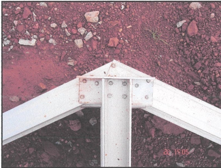
Gambarfoto 1: Pemasangan Kekuda
