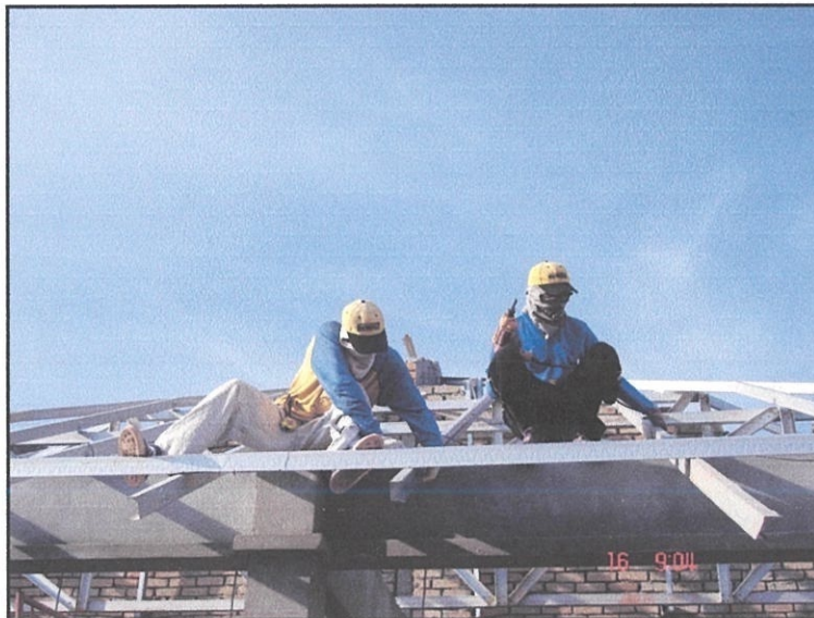
Gambar foto 6: Pemasangan Gulung-gulung
