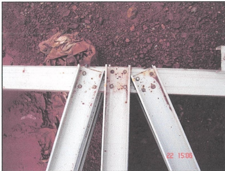
Gambarfoto 2: Penyambungan di bahagian bawah kekuda bumbung
