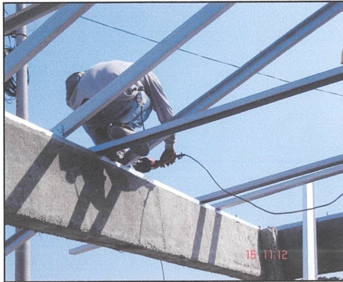
Gambarfoto 4: Kerja menskru antara 'wall plate' dengan kekuda
