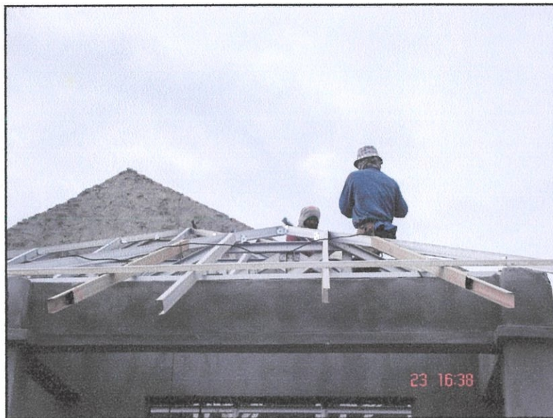
Gambar foto 7: Penyambungan setiap bahagian struktur kekuda
