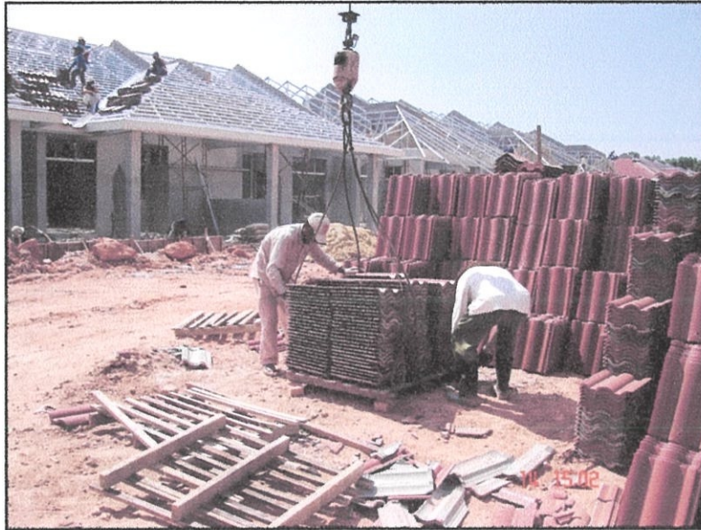
Gambar foto 8: Kerja mengangkat jubin
