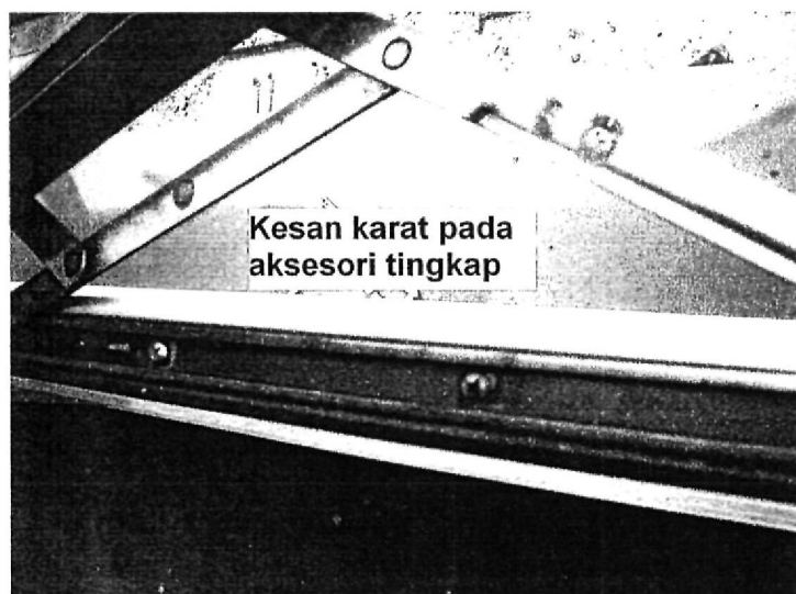
Foto 4.54 : Kelihatan kesan karat pada bingkai tingkap
