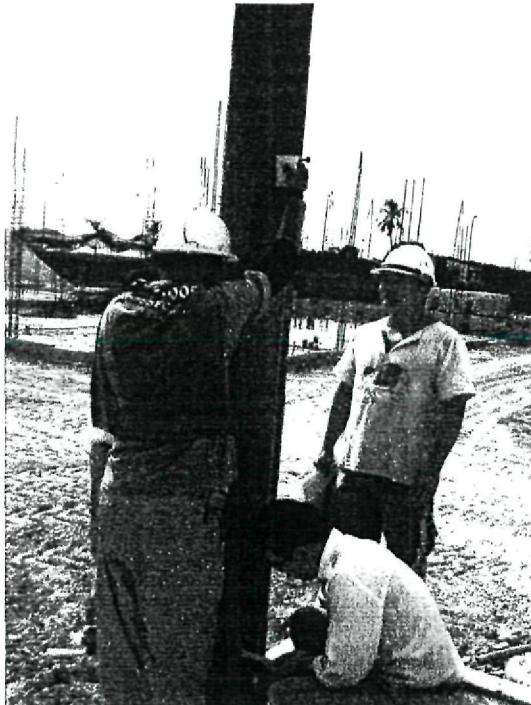
Foto 4.15 : Penilai sedang mengukur jarak dari benang ke tiang
