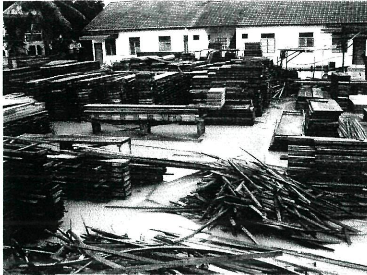
Rajah 4.13: keadaan acuan yang rosak akibat terkena air.
