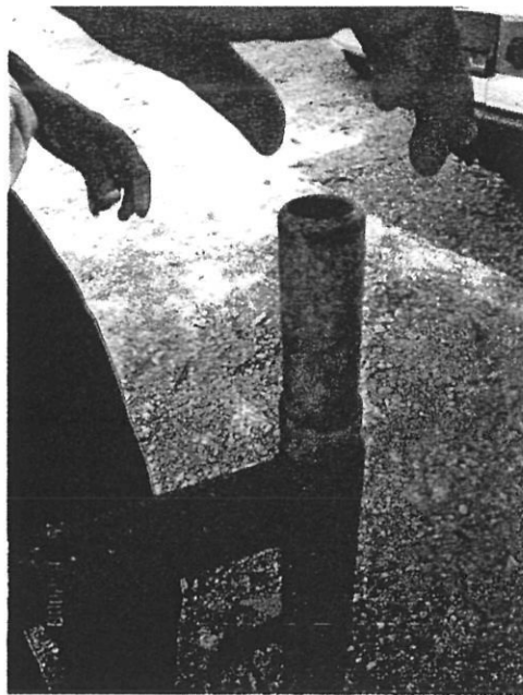
Gambarfoto 4.10 iv: Pin penyambung yang digunakan untuk menambah ketinggian kerangka tiub keluli.
