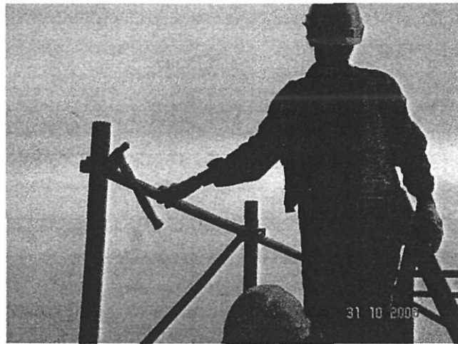
Gambarfoto 4.7 v: Pekerja sedang mengunci scaffold horizontal pada rosette menggunakan penukul.
