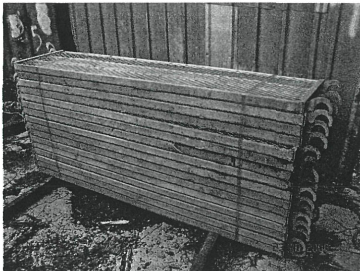
Gambarfoto 4.14 c: Pelantar kerja yang diikat rapi dan dialas dengan kayu disimpan di dalam setor.
