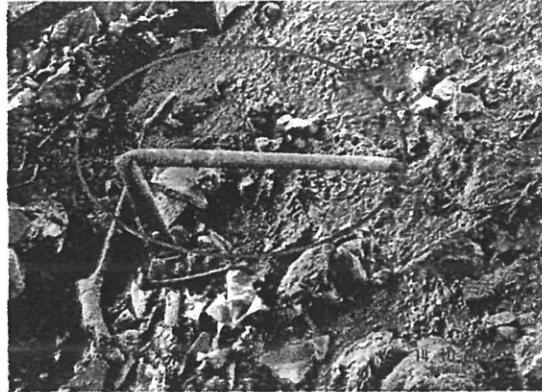
Gambarfoto 5.2.4 i: Rembat palang ( cross brace ) yang tertanam di dasar laut pada waktu air pasang.
