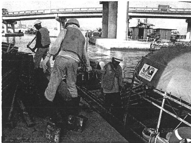
Gambarfoto 4.6.2 ii: Pekerja sedang mengangkut komponen-komponen perancah daripada bot.
