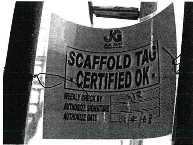
Gambarfoto 4.12 ii: Scafftag hijau dipasang pada perancah yang sempurna dan selamat dipasang.
