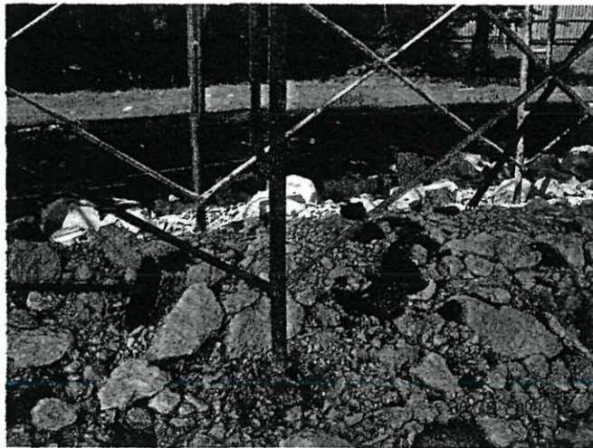
Gambarfoto 4.10.i: Penggalas yang dipasang pada tapak yang telah diratakan.
