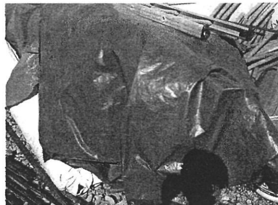
Gambarfoto 5.3.2 ii: Perancah yang ditutup dengan plastik kalis air.
