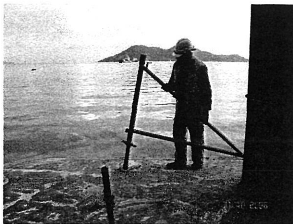
Gambarfoto 4.11 iii: Scaffold side bracket dimasukkan pada adjustable jack base .
