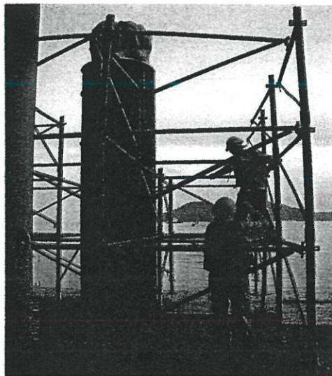
Gambarfoto 4.11vii: Side brackets bagi peringkat ketiga telah dipasang.
