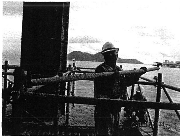
Gambarfoto 4.11 vi: Pekerja sedang melakukan pemasangan scaffold horizontal pada rosette .
