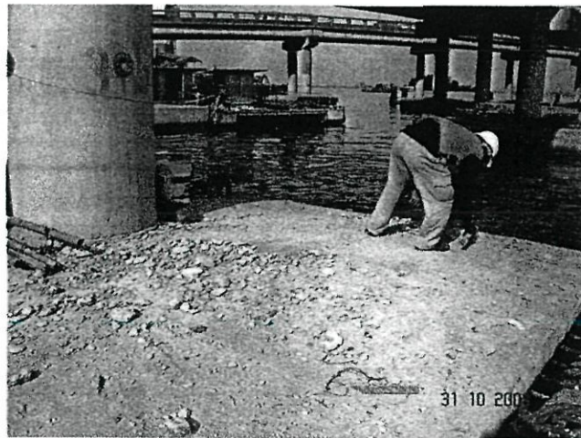
Gambarfoto 4.11 i: Pekerja sedang membersihkan tapak sebelum pemasangan dilakukan.
