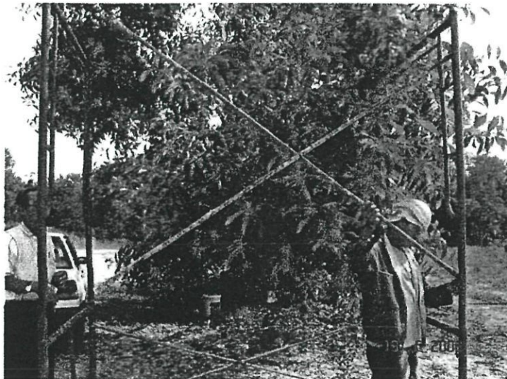
Gambarfoto 4.10 iii : Pekerja sedang memasang rerembat palang pada kerangka tiub keluli.
