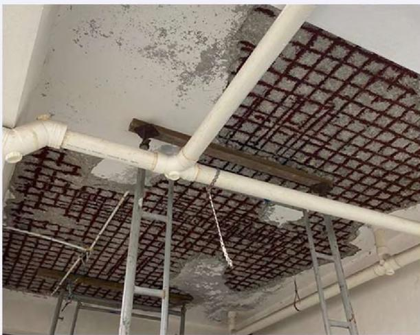
Keadaan *soffit slab* yang mengalami *concrete spalling* berskala besar di salah satu tandas Kolej Baiduri sebelum dibaikpulih.
