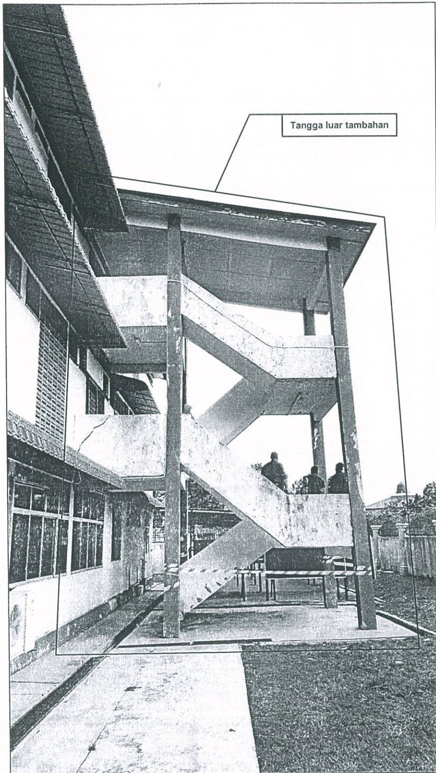
Gambar 3 : Salah satu tangga luar tambahan yang dibina berasingan dari bangunan asal asrama. Tangga ini terletak di bahagian belakang Blok E dan telah ditutup dari sebarang penggunaan. Tiada keretakan struktur dikesan pada mana-mana komponen struktur tangga ini.
