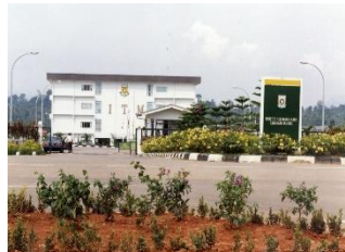
Bangunan Pentadbiran ITM Pahang di Jengka siap dibina pada tahun 1992.
