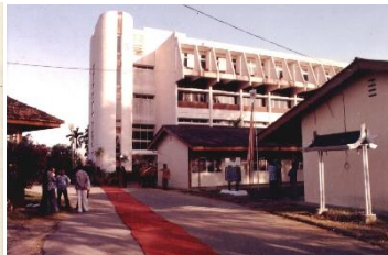
Bangunan ITM Pahang di Kuantan. Bangunan ini asalnya Bangunan Pejabat Lambaga Kemajuan Pahang Tenggara, Jalan Telok Sisek, Kuantan.
