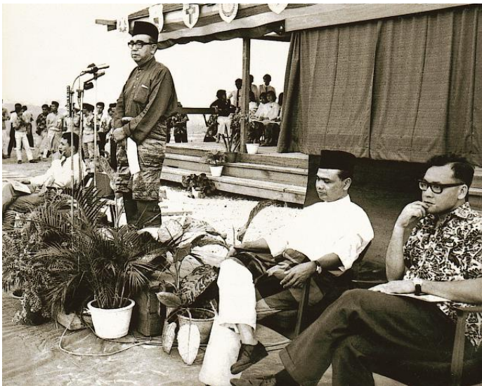
YAB. Tun Abdul Razak bin Hussein, Timbalan Perdana Menteri Malaysia sedang memberi ucapannya pada Upacara Peletakan Batu Asas ITM Batu Tiga, Jalan Klang Selangor
